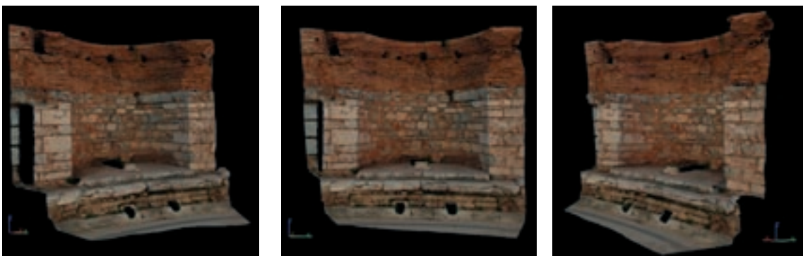
8 Drei Ansichten des 3-D-Modells der zentralen Apsis der Celsusbibliothek, beruhend auf einem einzigen Scan
