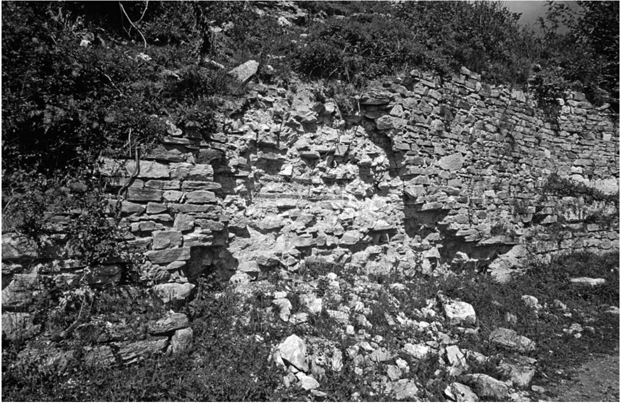
133 Sergentzion (Binkılıç), O-Mauer, Außenseite mit Vorbau
