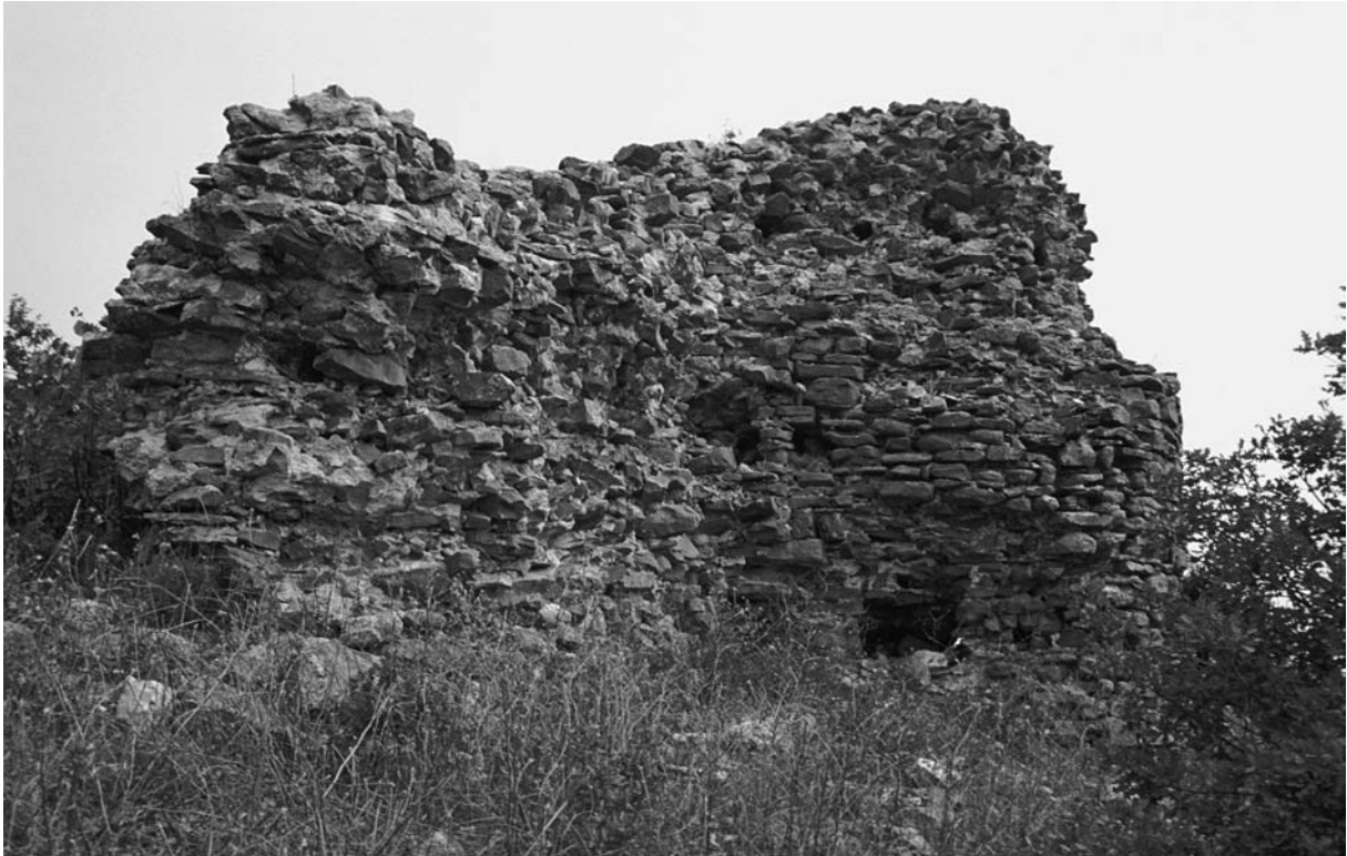
113 Naip Kalesi, O-Mauer mit Turmansatz
