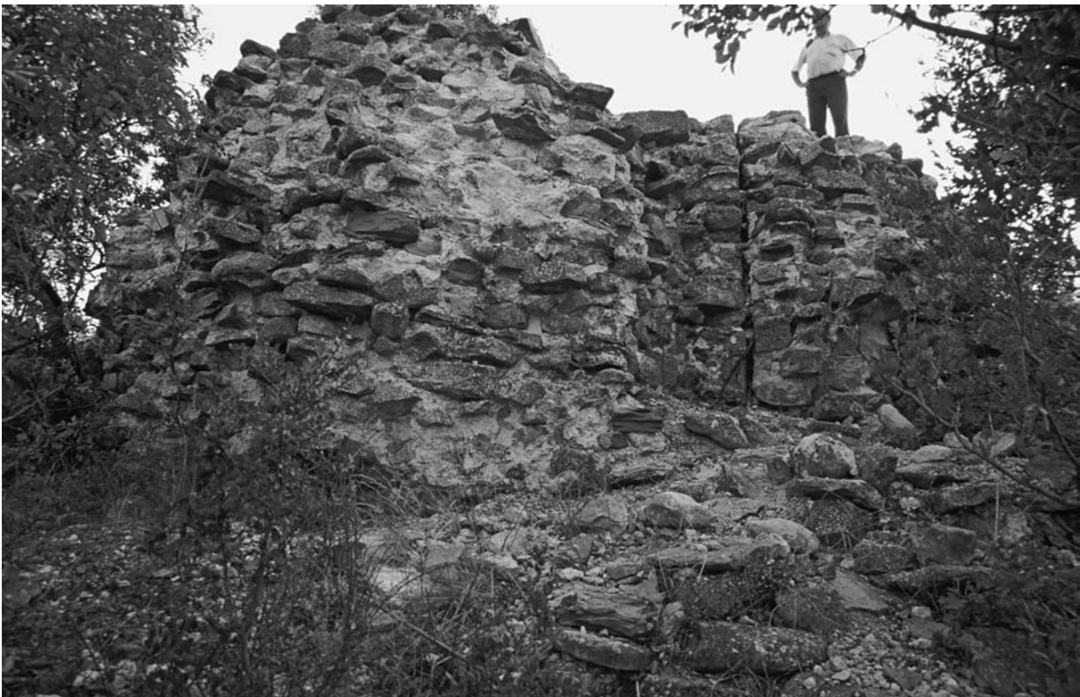
120 Pişmanköy, S-Mauer, Außenseite
