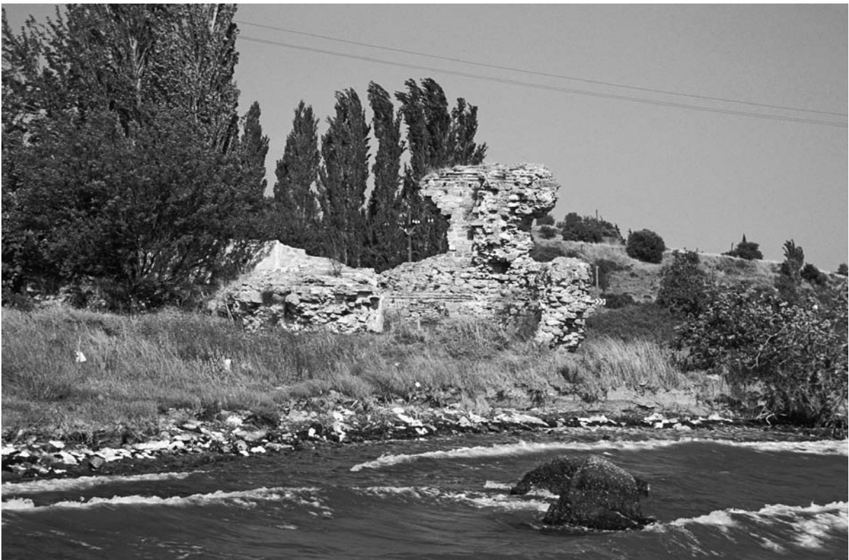
88 Koila, Teil der Festungsmauer von WSW
