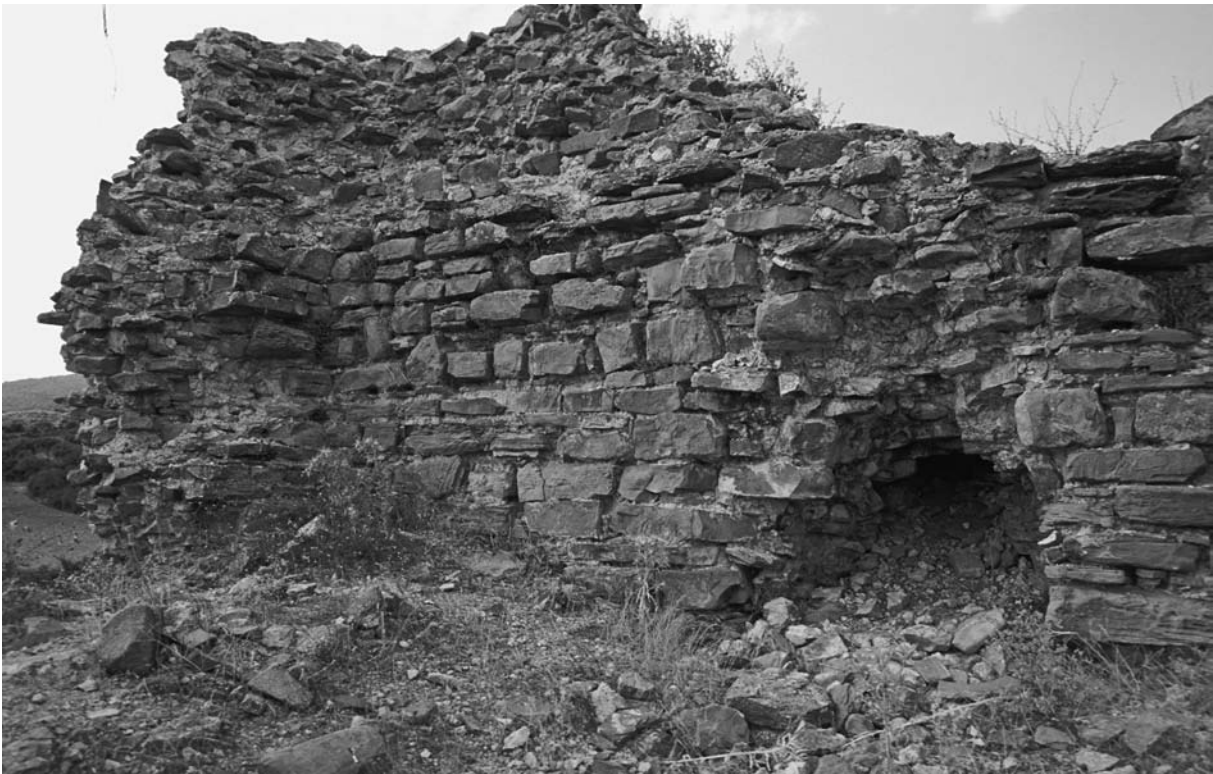
76 Kale alti, S-Mauer, Außenseite
