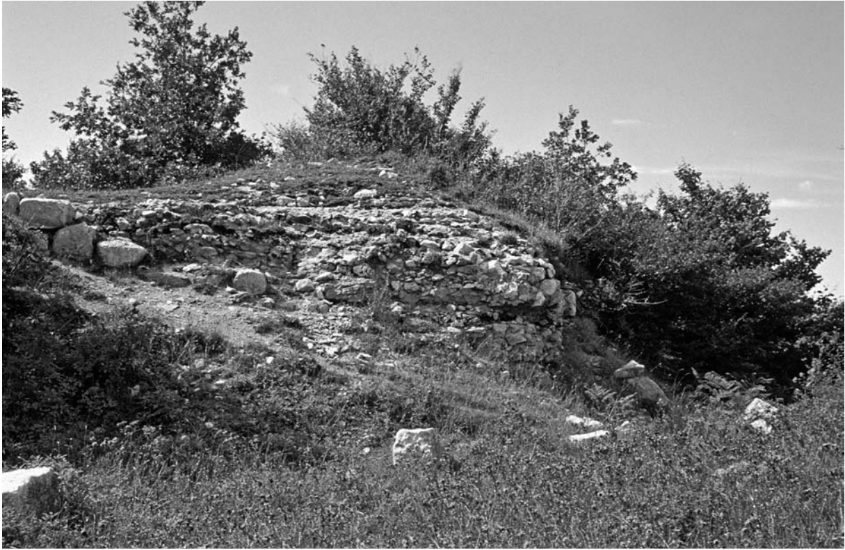
131 Sergentzion (Binkılıç), N-Mauer, Außenseite
