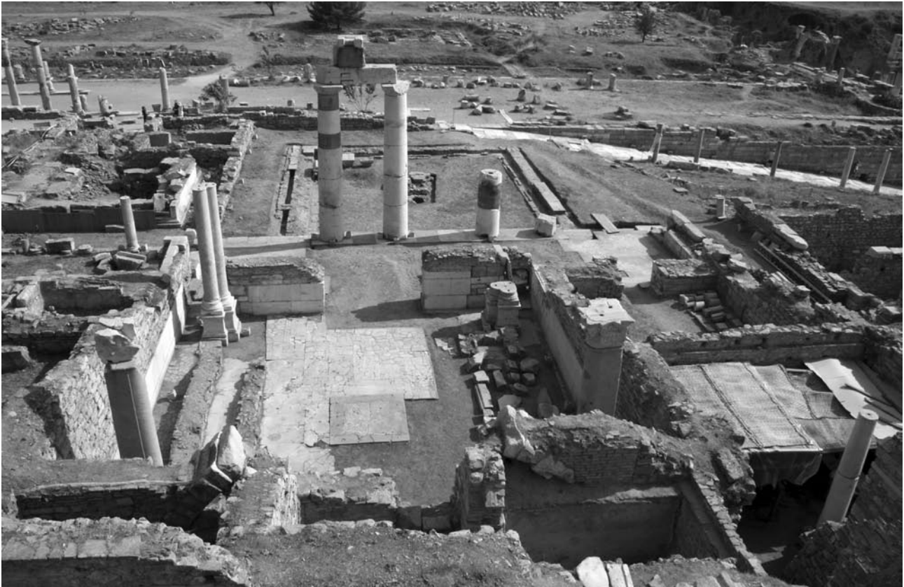
1 Prytaneion von Ephesos – Hestiasaal. Blick nach Süden
