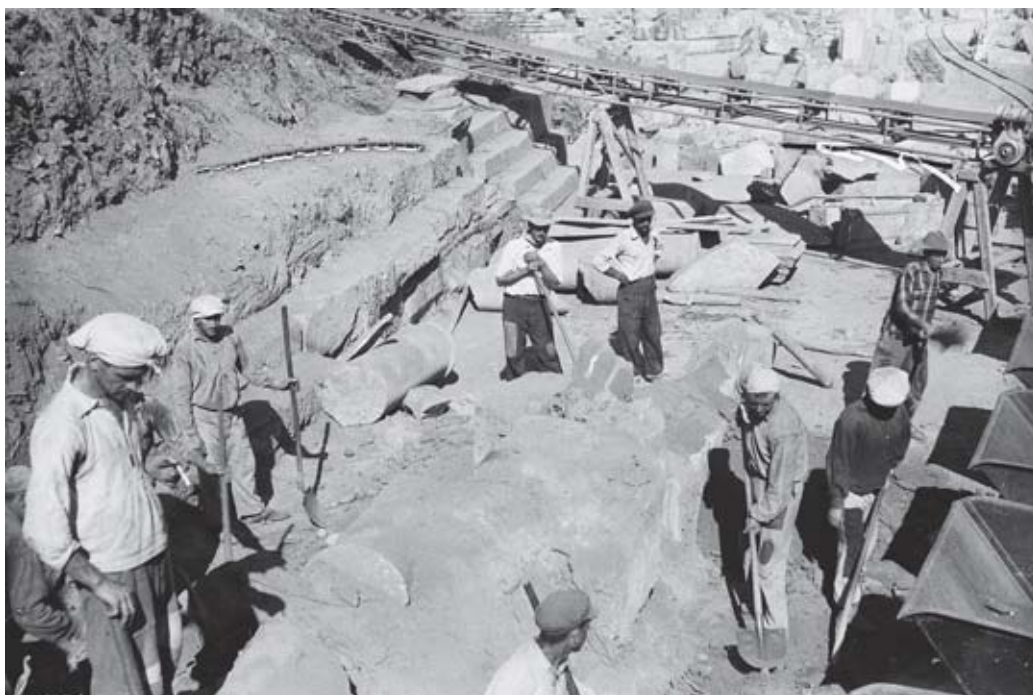
Abb. 2: Schuttsperre, im Hintergrund die Aletarchenstoa
