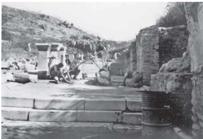
Abb. 9: Treppe in Ansicht
