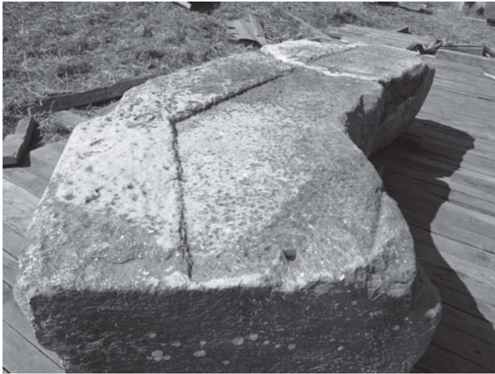
Abb. 11: Durchlaufende Abarbeitung an der Oberseite zweier benachbarter Blöcke
