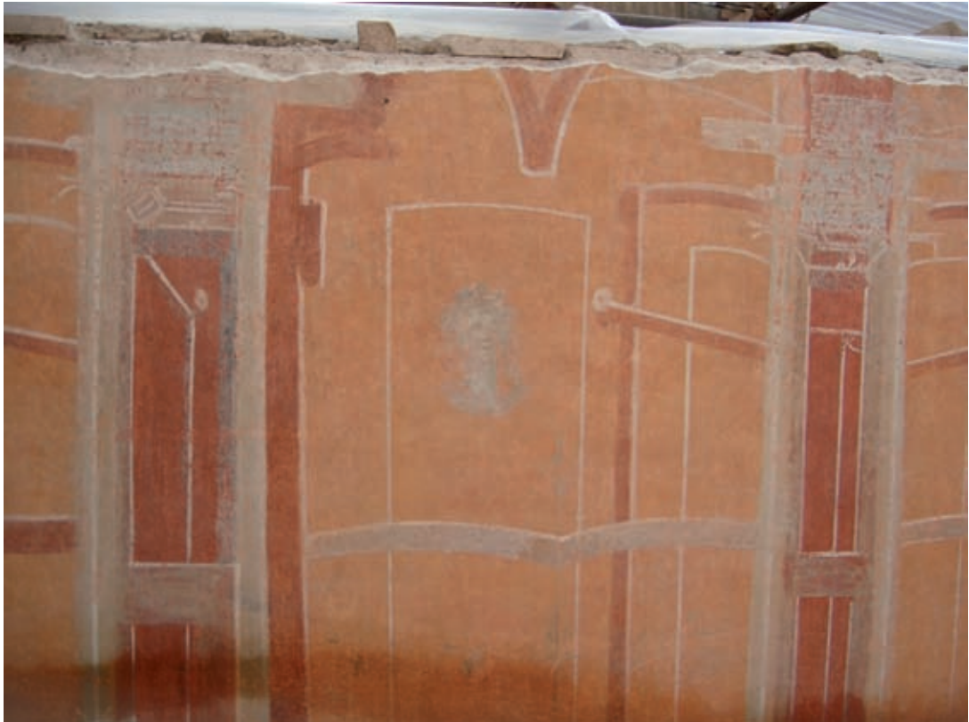
Fig. 35: Pitture dell'ambiente 11 dell'Insula delle Ierodule (foto S. Falzone).
