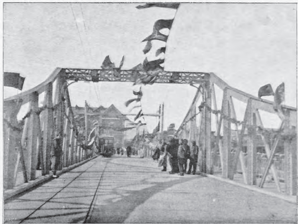
Die kürzlich eröffnete österreichisch-ungarische Brücke, welche die Chinesenstadt mit unserer Niederlassung verbindet.
