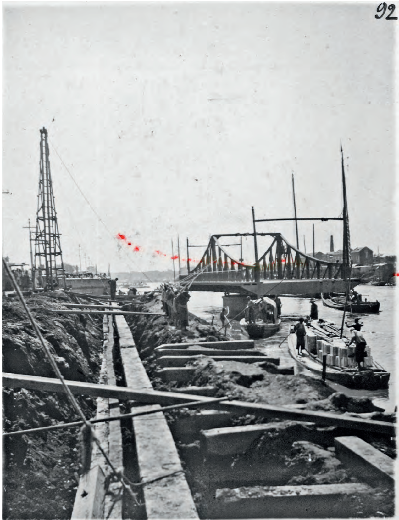
Bild 92 zeigt die in Konstruktion befindliche Quaiwand nördlich der Drehbrücke mit Blick gegen Süden, aufgenommen vom Endpunkte der Uferkonstruktion in der Höhe der Hsin Lung Chie (Stand der Arbeiten um Mitte September 1911).
