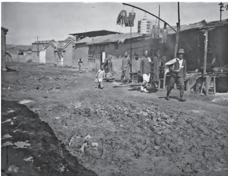
Bild 71 zeigt eine der an der Grenze der italienischen Niederlassung führenden Parallelstraßen zur Hauptstraße, durch welche sich das Hochwasser am 30. August d.J. einen Weg gegen das Sammelbassin zu bahnte; dieselbe mündet bei dem auf Bild 70 am linken Rande ersichtlichen chinesischen Wohnhaus an die italienische Grenze.
