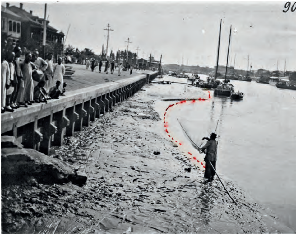
Bild 90 zeigt die regulierte Quaifront südlich der Drehbrücke in ihrer ganzen Längenausdehnung, von der Drehbrücke aus aufgenommen. Das Schwemmland südlich der Drehbrücke ist in seiner ganzen Breitenausdehnung sichtbar.
