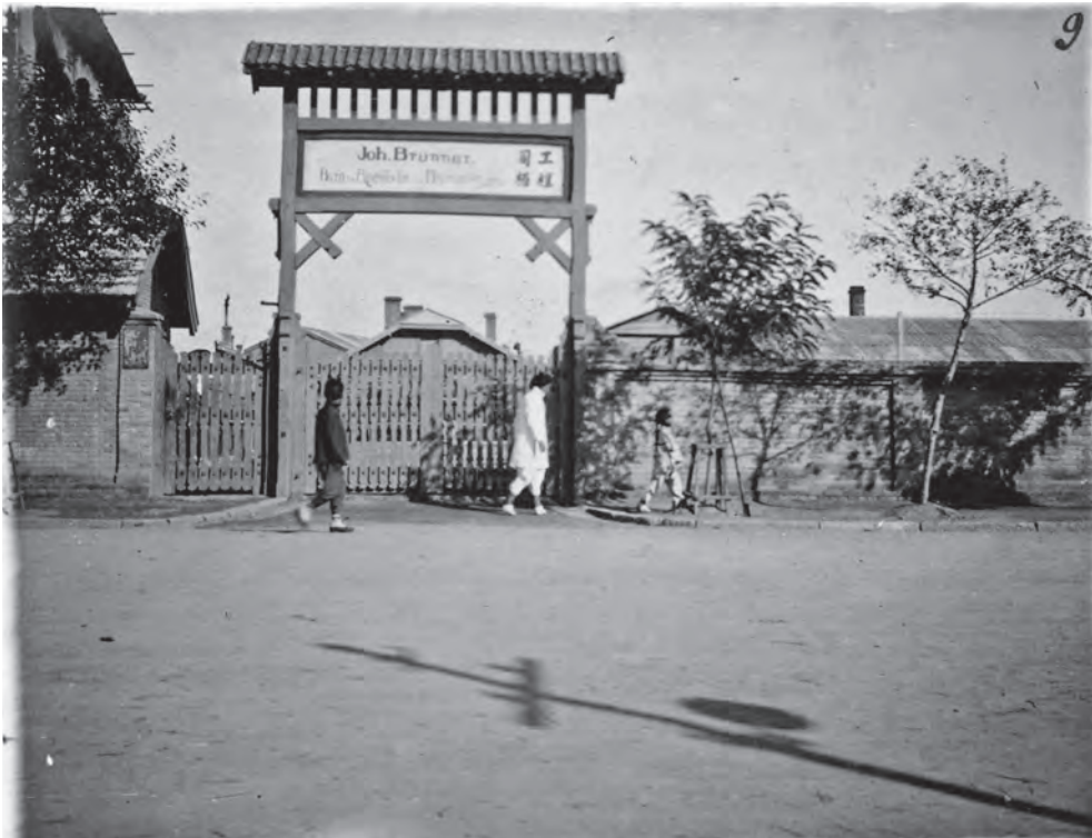
Bild 9 Eingang zum Grundstück der Baufirma Johann Brunner
