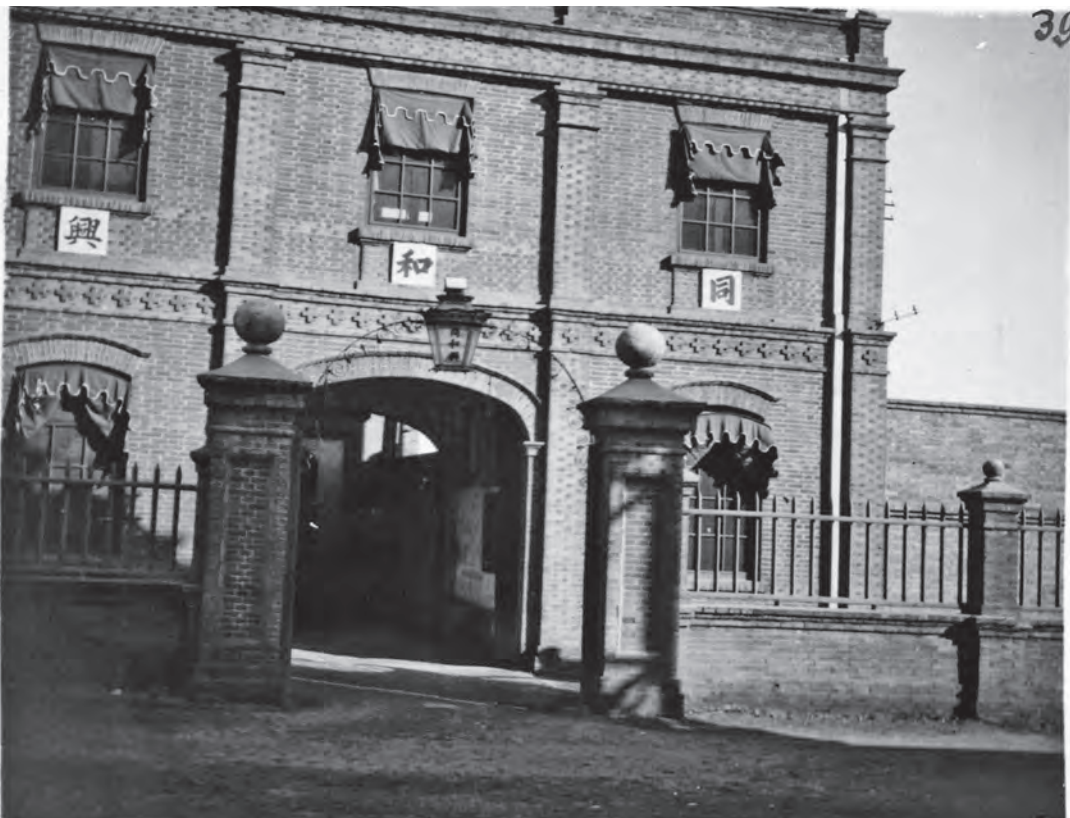
Bild 39 eines der besser gebauten chinesischen Hotels der H.B.G.
