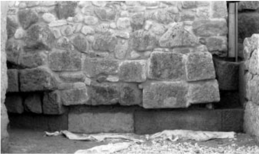
15 Mauerzug unter dem Südwestflügel der westlichen Analemma-Mauer
