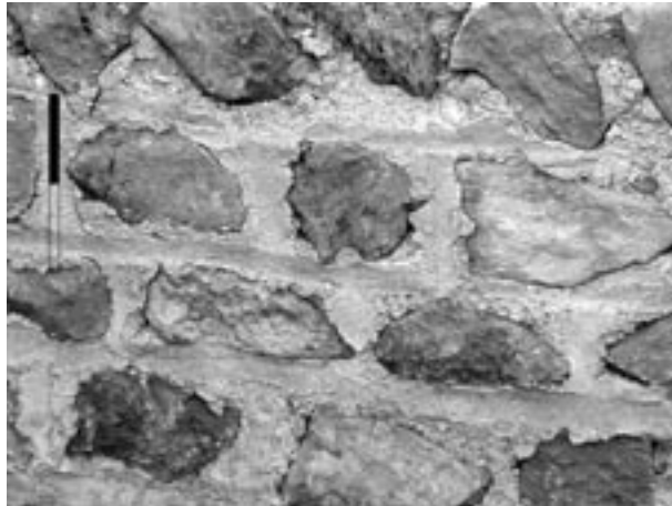
3 Fugenstrichmauerwerk in Raum 27
