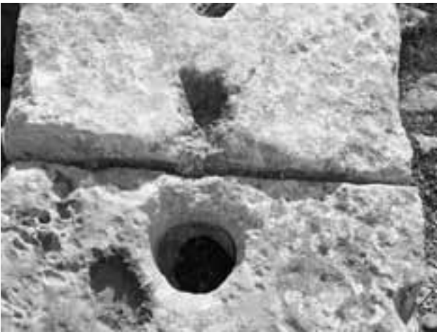
Abb. 36 Steinrohrglieder mit Entlüftungsloch und Klammerloch
