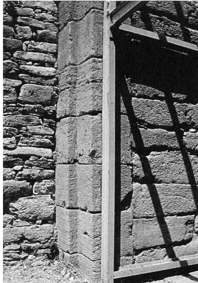
Abb. 81: Myron/Peristeria, Tholos 1, Fassade des Stomions
