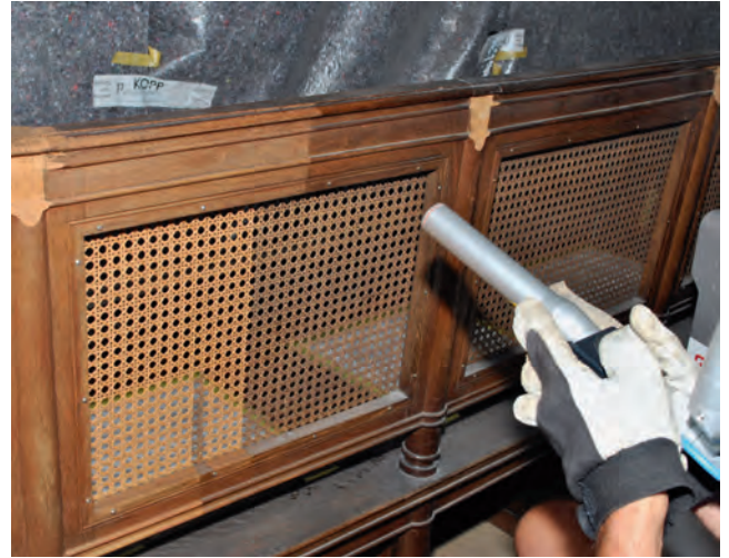
Abb. 2: Bundesversammlungssaal, Galerie, Klappsitz mit Wiener Geflecht während der Laserreinigung, 2019
