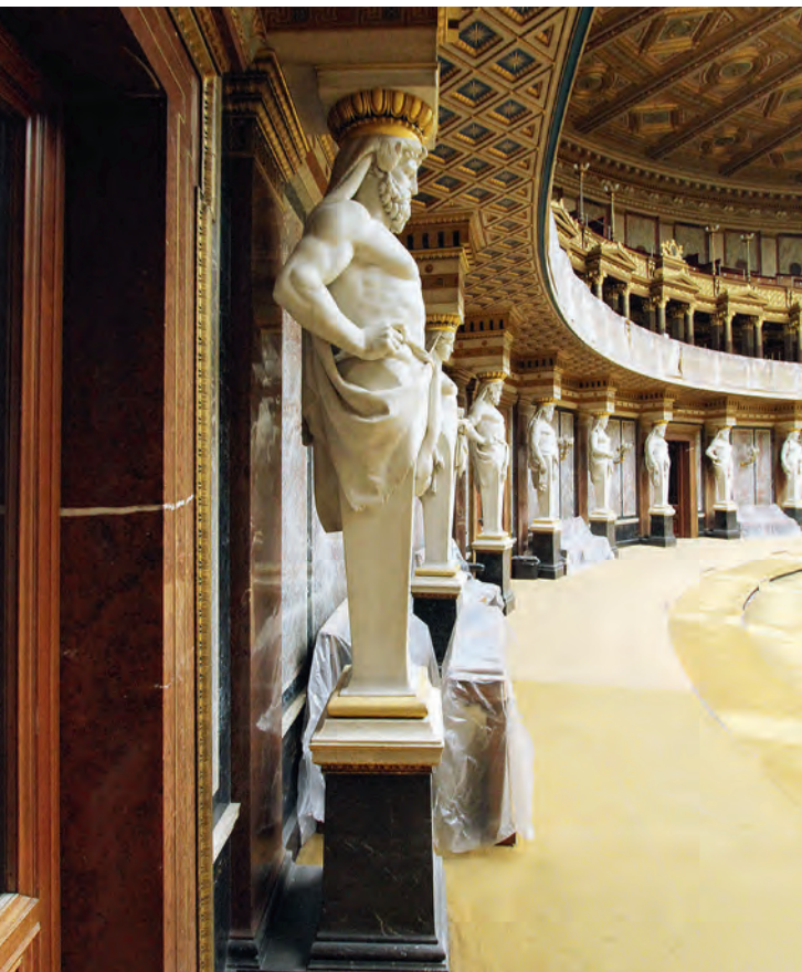
Abb. 1: Übersichtsaufnahme Atlanten mit Sockeln, Vorzustand
