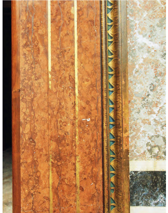
Abb. 3: Türeinfassung mit schadhafter Vergoldung und Polychromie, Vorzustand
