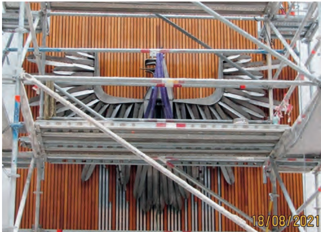
Abb. 3: Adlermontage mit Gerüst
