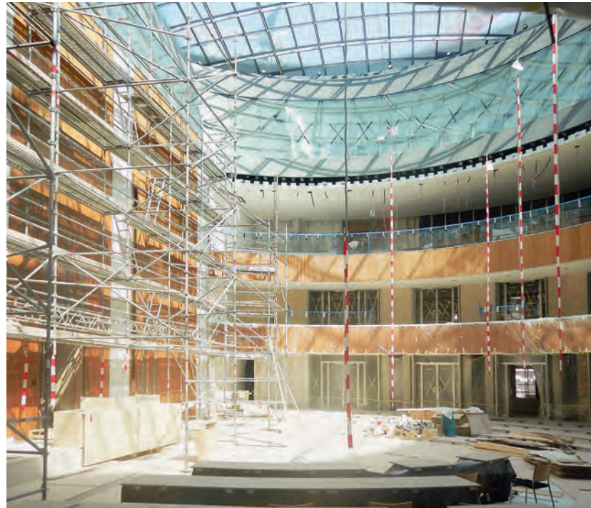
Abb. 5: Nationalratssitzungssaal während der Restaurierungsarbeiten
