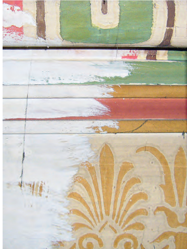
Abb. 6: Befund teilverdeckter Fassung der Fries- und Architravzone, 2006
