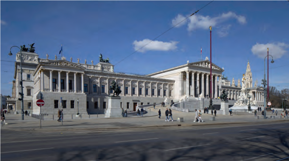
Abb. 2: Fassade zum Ring nach Sanierung, am linken Eckrisalit restaurierte polychrome Fassungsachse (siehe auch Beitrag von Markus Pescoller), Aufnahme März 2023
