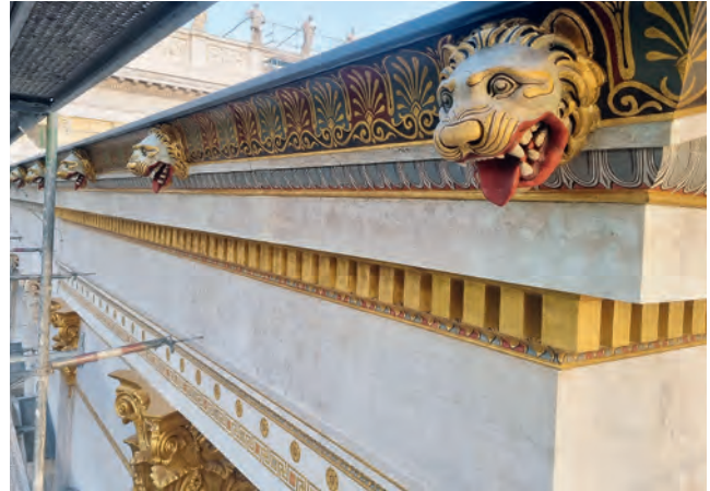
Abb. 8: Hauptgesims nach der Rekonstruktion der Fassung, Aufnahme 2021
