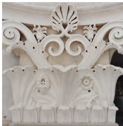
Abb. 5: Sandgestrahltes Kapitell nach der Kittung, Aufnahme 2021
