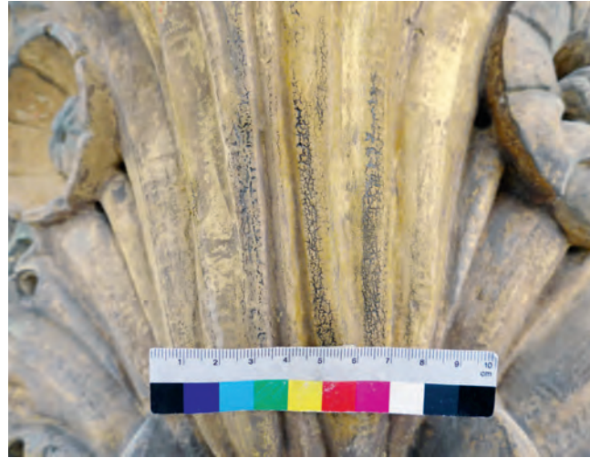
Abb. 2: Ausschnitt vom Kapitell am Eckrisalit mit schwarzer Nachzeichnung, sichtbar an den Rissen der Vergoldung von 1939, Aufnahme 2021
