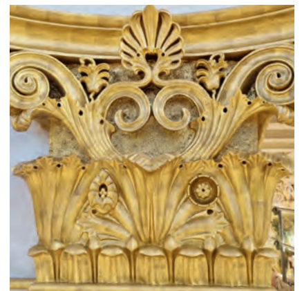
Abb. 6: Kapitell nach der Rekonstruktion der Fassung, Aufnahme 2021
