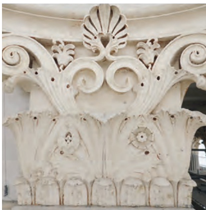
Abb. 4: Sandgestrahltes Kapitell, Aufnahme 2021
