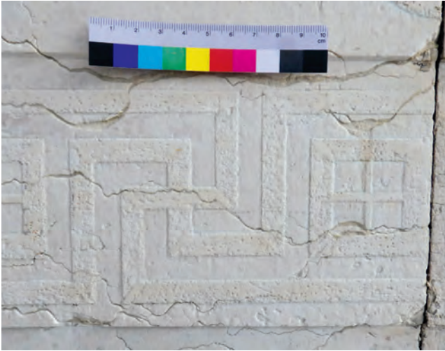
Abb. 1: Ausschnitt Mäander Kranzgesims, präzise Reliefierung der Zeichnung, an den Kanten Spuren eines Breitmeißels, Aufnahme 2021
