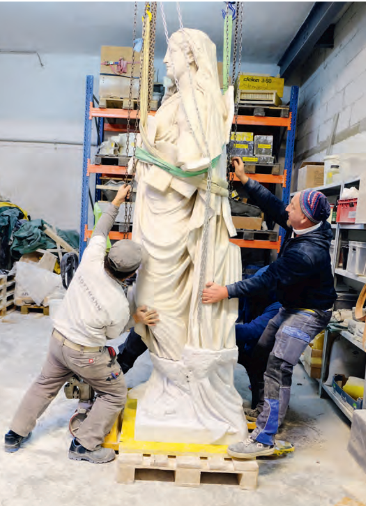
Abb. 5: Versetzen der Figur „Klugheit“ auf die neu ausgeführte Natursteinerfüllung (Laaser Marmor)
