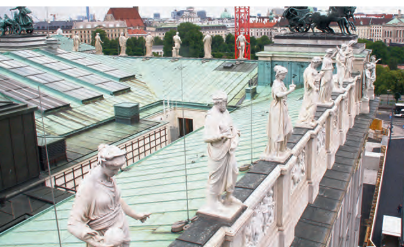
Abb. 1: Die Attikafiguren vor der Demontage, Seite Schmerlingplatz
