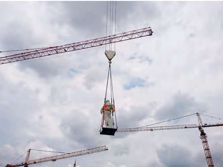
Abb. 2: Demontage der Attikafiguren mittels Kran, Figur „Geodäsie“
