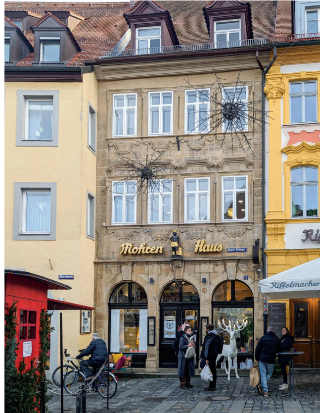
Abb. 2: Blick auf die Fassade des M.-Hauses, Obere Brücke 14, Bamberg
