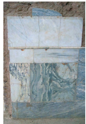
Abb. 7: SR 22/23: Ostseite, Reparatur der Marmorwandverkleidung bei SR 17
