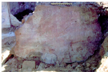
Abb. 22: Sturzmauer aus SR 22/23
