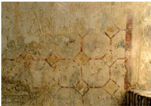
Abb. 15: GEW B, Gewölbetonne
