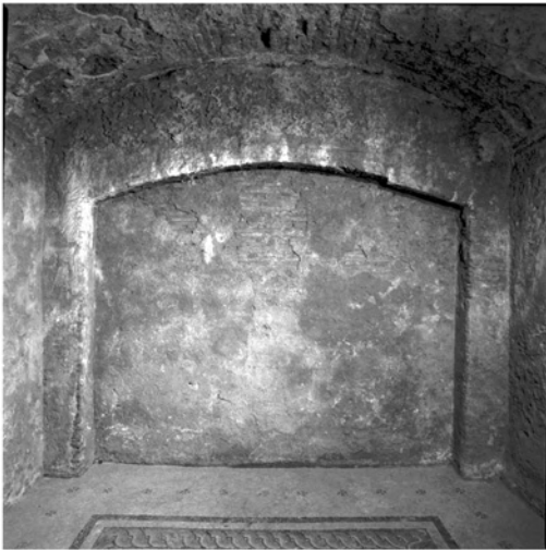
Abb. 31: S-Mauer von GEW C
