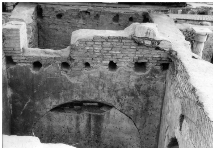
Abb. 54: Blick auf die Balkenlöcher in den N-Mauern von SR 11 und SR 12 sowie auf die Tür zwischen den OG-Räumen SR 11.1 und SR 12.1
