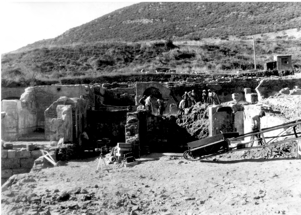
Abb. 2: Blick von N auf SR 19/20 und SR 24 während der Freilegung
