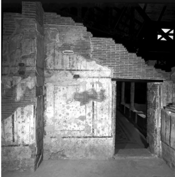
Abb. 13: Teil der O-Mauer von SR 27
