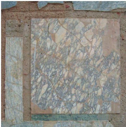
Abb. 3: SR 22/23: Westseite, Detail der Marmorwandverkleidung
