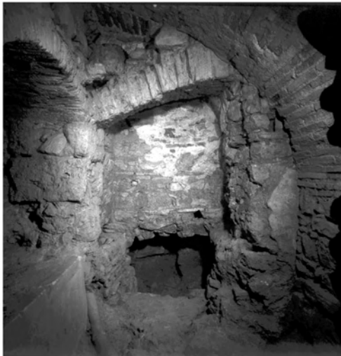
Abb. 7: Nördlicher Teil der O-Mauer von SR 1/6
