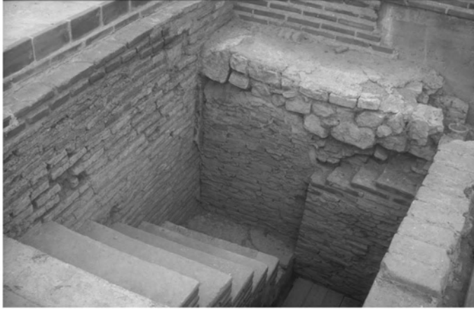
Abb. 36: Treppe und S-Mauer von SR 2b
