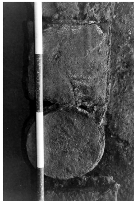
Abb. 20: Feinputz um Hypokaustpfeiler
