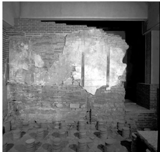
Abb. 19: S-Mauer von SR 3
