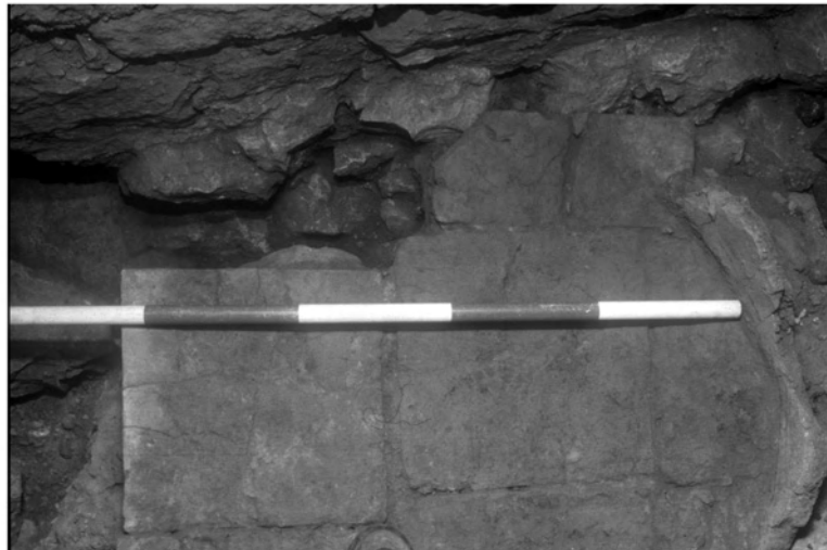
Abb. 19: SR 30, Ofen 6, Bodenplatten und Ofenwand
