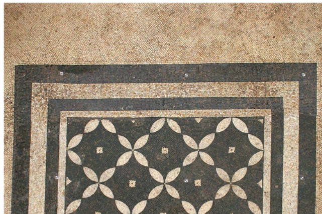
Abb. 19: Mosaik SR 22/23–Nord. Detail Ausbesserung östliches Musterfeld
