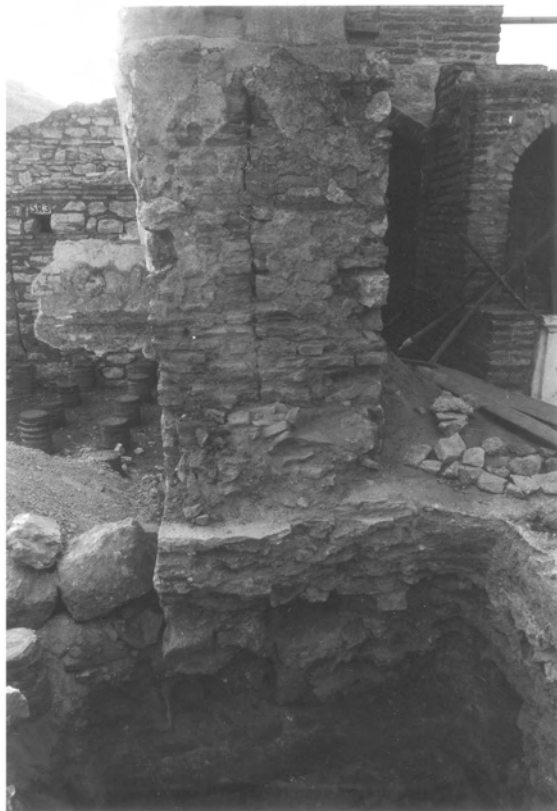
Abb. 20: Blick von W auf die Trennmauer zwischen SR 3 und SR 1
