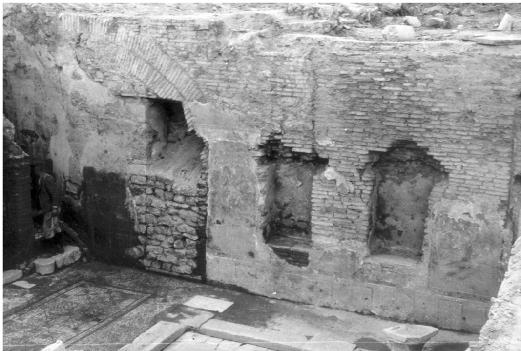
Abb. 51: W-Mauer von SR 2 mit spätantiker Abmauerung der Tür nach SR 11
