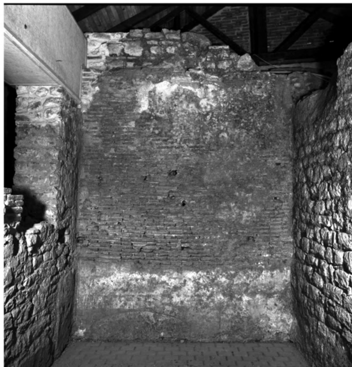
Abb. 5: S-Mauer von SR 30
