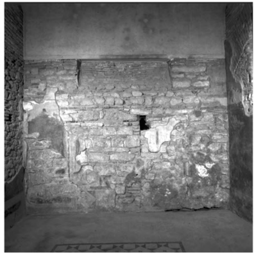
Abb. 6: Südlicher Teil der O-Mauer von SR 1/6
