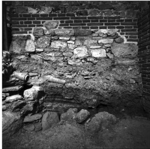
Abb. 48: S-Mauer von SR 5b
