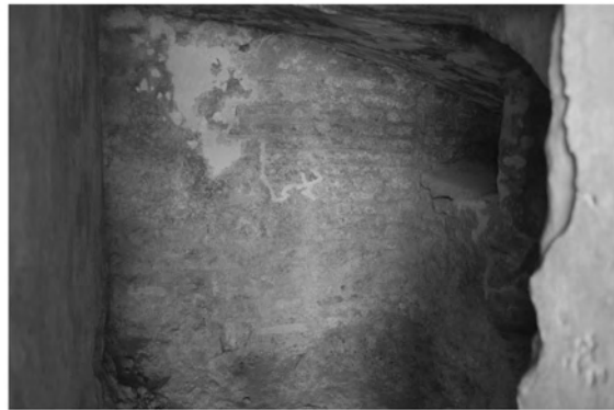
Abb. 32: S-Mauer von SR 2a
