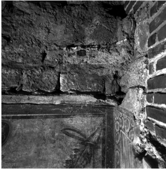
Abb. 9: SW-Ecke von SR 22/23 mit Rest der Bodenunterkonstruktion mit Mosaik des OG
