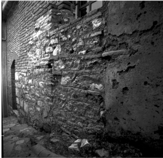
Abb. 21: Außenmauer von SR 3 mit abgemauerter Wandnische
