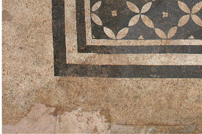
Abb. 17: Mosaik SR 22/23–Nord. Detail Ausbesserung südwestlicher Bereich
