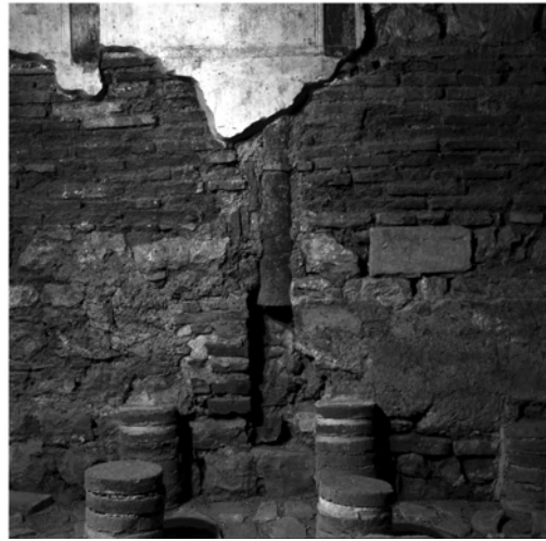
Abb. 47: S-Mauer von SR 3 mit Abzugsrohr
