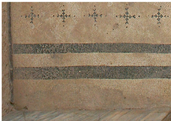
Abb. 36: Mosaik SR 24. Detail Ausbesserung in der südwestlichen Außenzone
