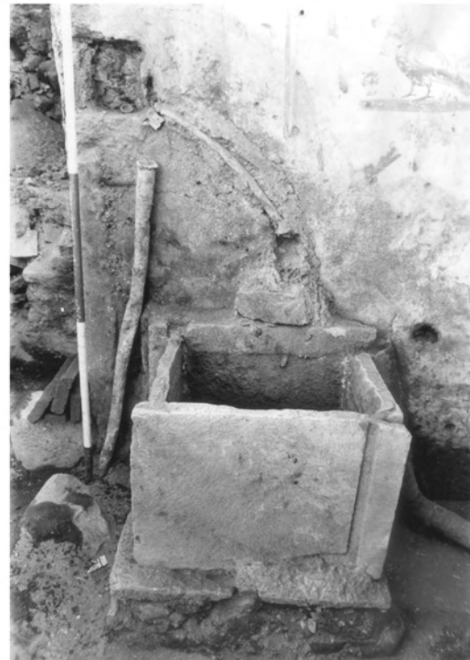
Abb. 19: Spätantiker Brunnen, Mauerausnehmung für Verteilerkasten und Bleihrleitungen an der S-Mauer von SR 27
