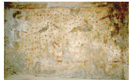
Abb. 3: GEW A, Südwand
