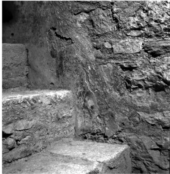
Abb. 18: An ältere Wandmalerei angesetzte Treppe in SR 1
