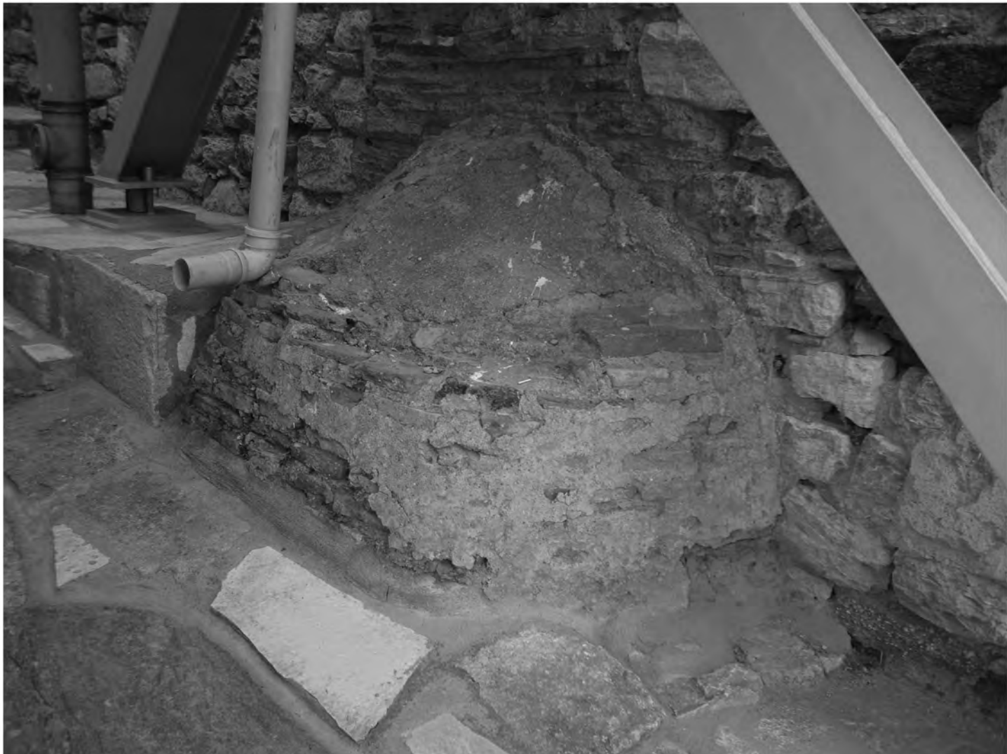
Abb. 14: STG 1, W-Mauer, Kuppel des Apsidenbeckens WB-B3
