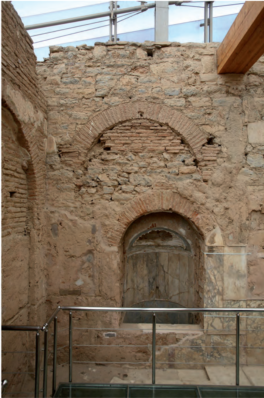
Abb. 2a: Frigidarium M3, Blick auf die Ostwand
