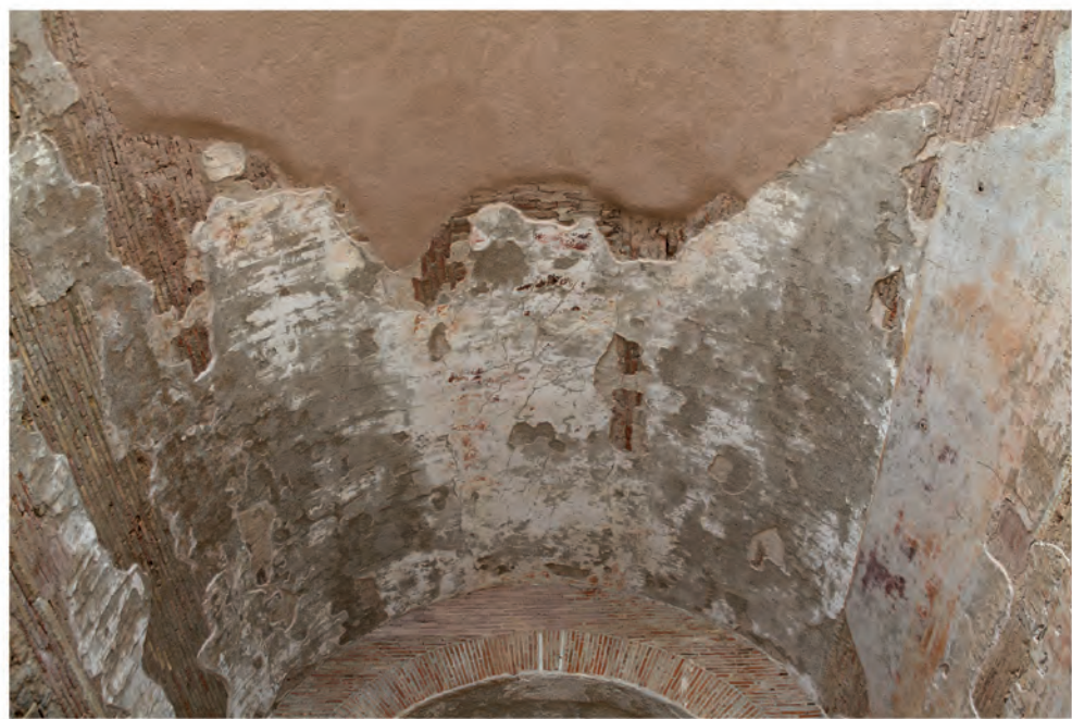
Abb. 43: Apsidensaal 8, westliches Gewölbe
