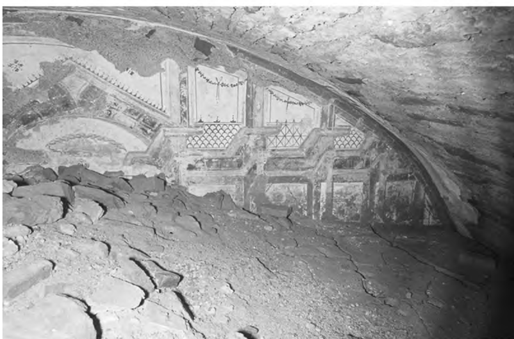
Abb. 22: Schuttverfüllung im Gewölberaum 36a
