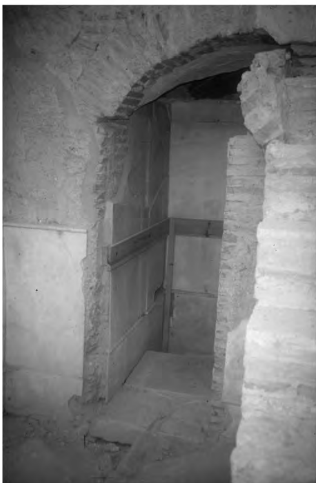
Abb. 16: Eingang zur Latrine 36bL
