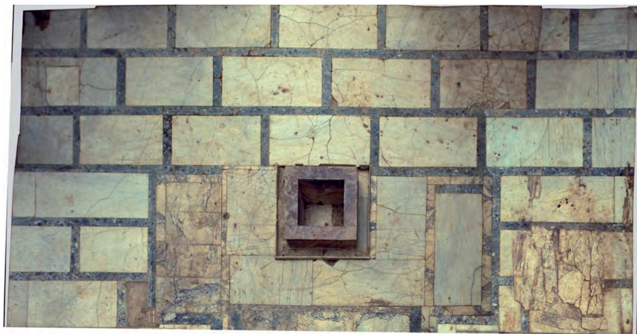
Abb. 2: Marmorsaal 31, Bodenbelag im N-Teil des Raumes
