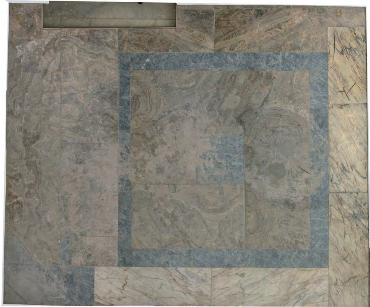
Abb. 31: Gewölberaum 36a, Boden
