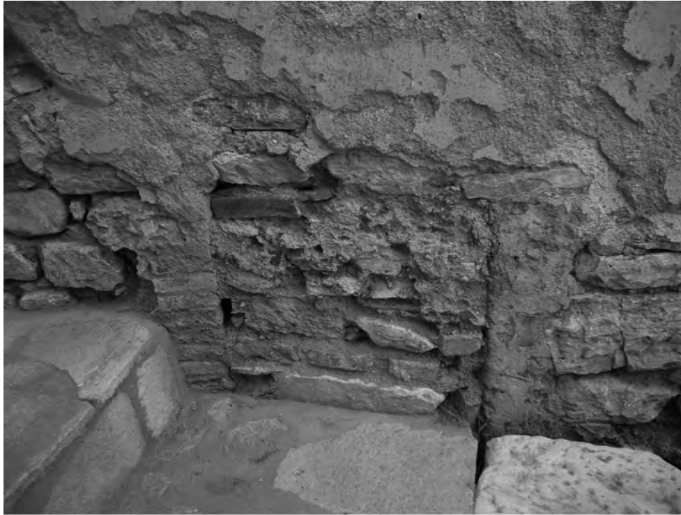
Abb. 1: STG 1, vermauertes Praefurnium zum Raum 31aO/M2
