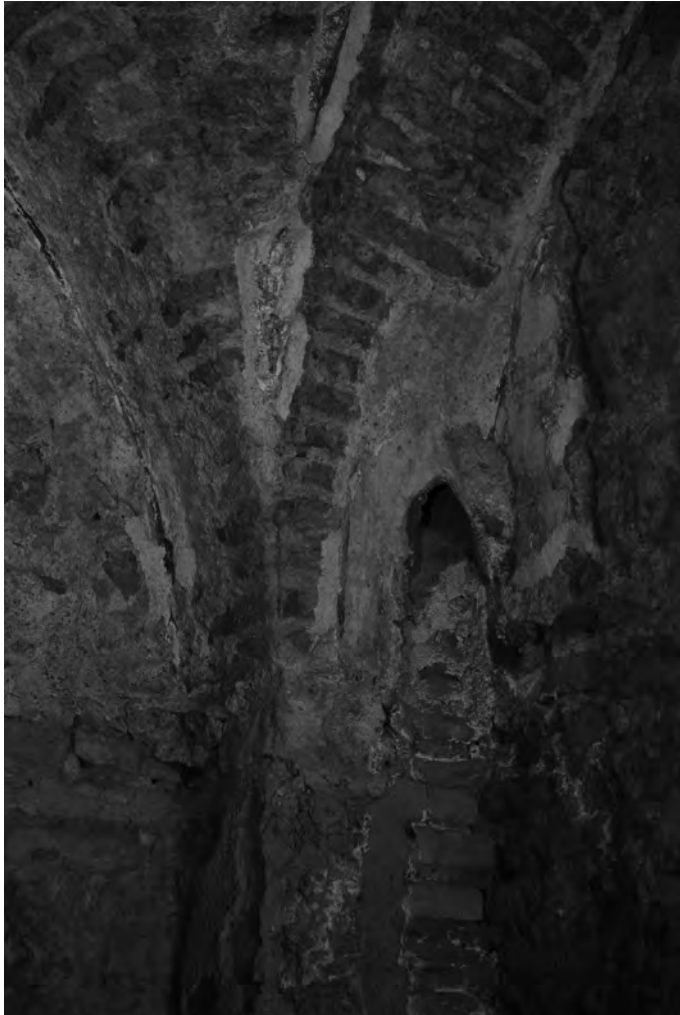
Abb. 5: Tonrohre als Rauchabzug im Bad 31aO
