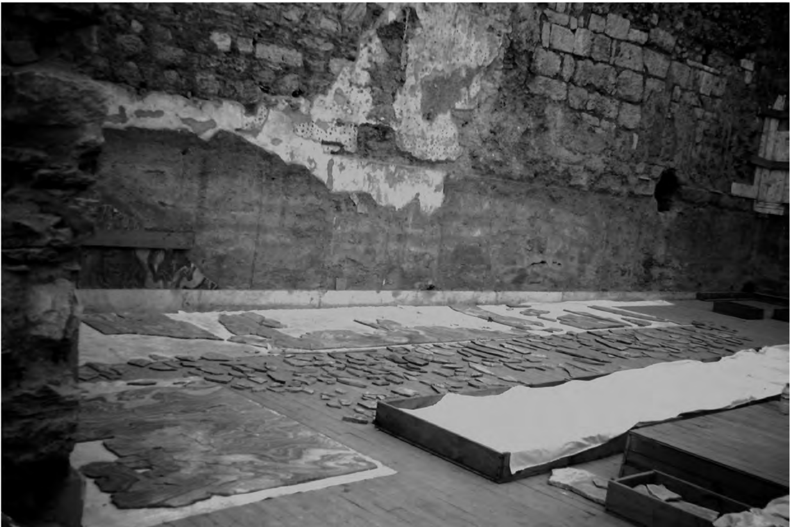
Abb. 19: Marmorsaal 31, O-Wand mit Baufuge
