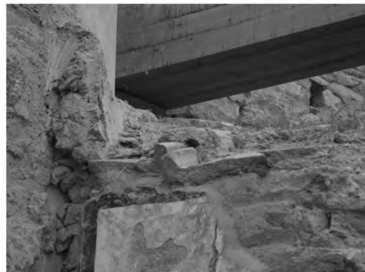
Abb. 45: Peristylhof 31a, Apsidenbecken WB-B4, Reste der Ziegeldeckung
