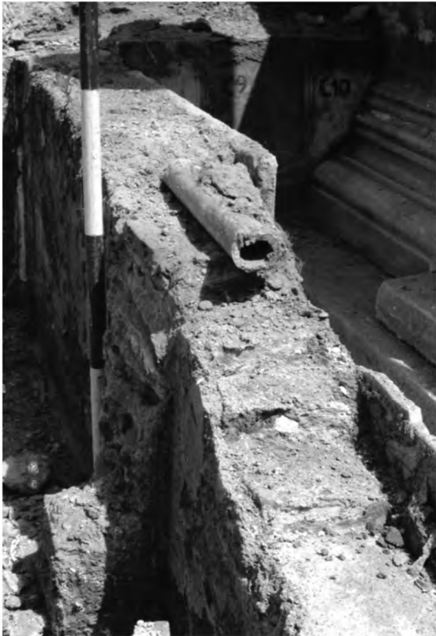
Abb. 38: Bleirohr in Brüstungswand Brunnenbecken WB-A3
