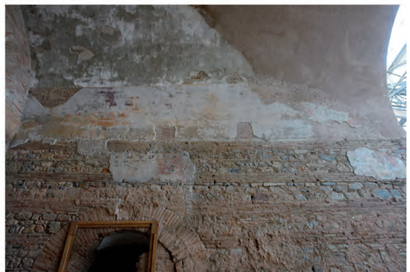
Abb. 45: Apsidensaal 8, W-Seite des Gewölbes, gesamt
