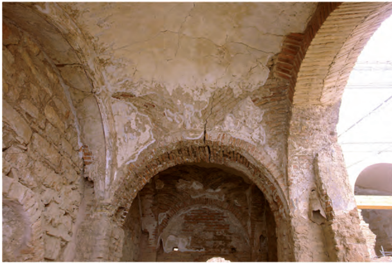
Abb. 12: Raum 31aO.M1, Rest der Stuckverzierung der Decke
