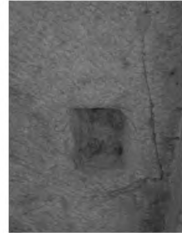
Abb. 16: Tür T 23, Ausnehmung für Türangel im Türsturz
