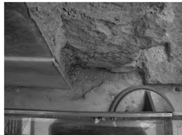
Abb. 20: Tür T 20 im Raum 36, Ausnehmung für Türrahmenprofil im Boden
