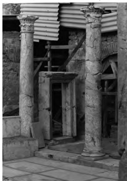
Abb. 11: Peristylhof 31aW, Marmortürrahmen A 38 nach der Konservierung
