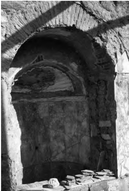
Abb. 10: Raum 31aSO/M3, Apsidenbecken WB-B3 in O-Mauer
