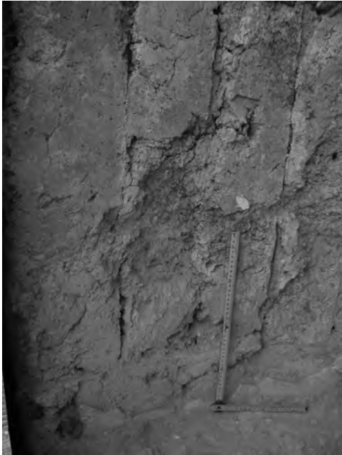
Abb. 23: Marmorsaal 31, Apsisbrunnen WB-A2, Abdrücke der Marmorverkleidung
