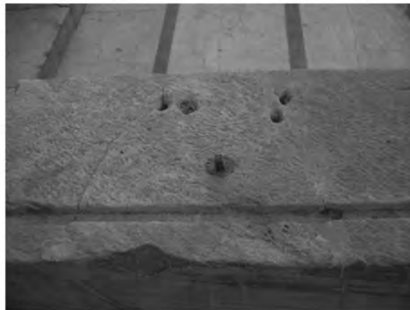
Abb. 12: Oberes Auflager des Schrankenplatten-Gesimses in 31aS mit Metallhaken für Skulpturensockel
