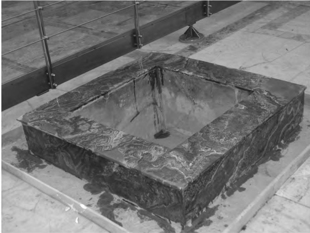
Abb. 22: Marmorsaal 31, Bodenwasserbecken WB-A4 im N-Teil
