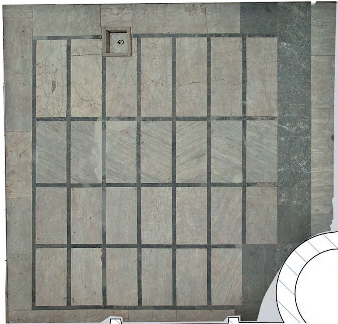
Abb. 1: Peristylhof 31a, Boden
