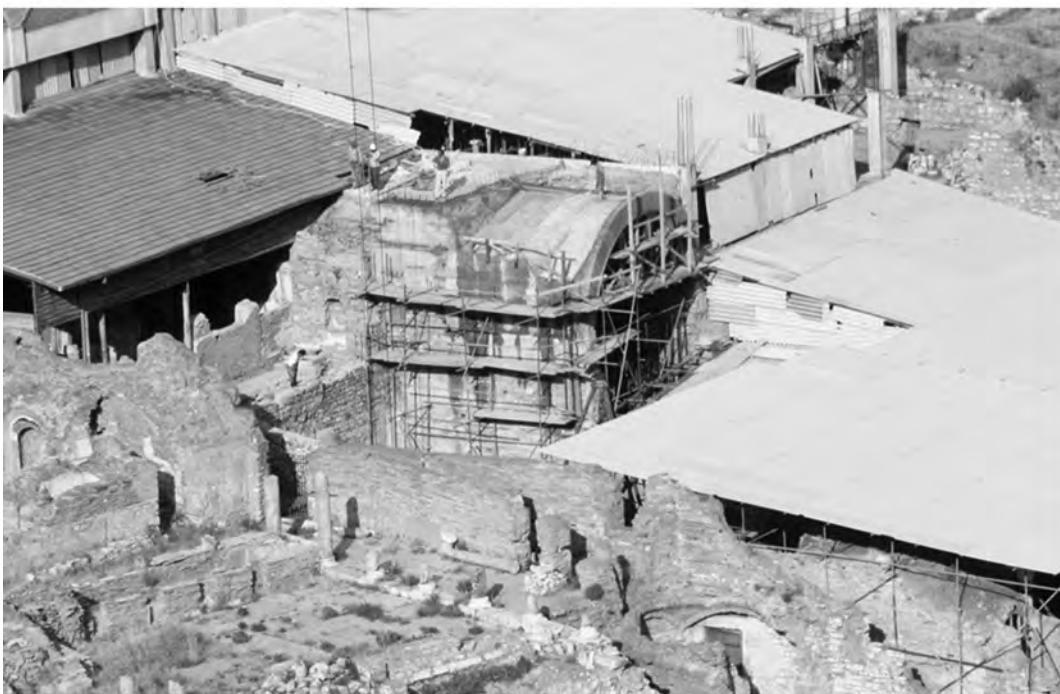
Abb. 45: Ergänzung der Betontonne über dem Apsidensaal 8
