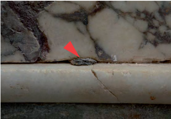
Abb. 29: Verteilerraum 36, Bleiplättchen (N-Wand)
