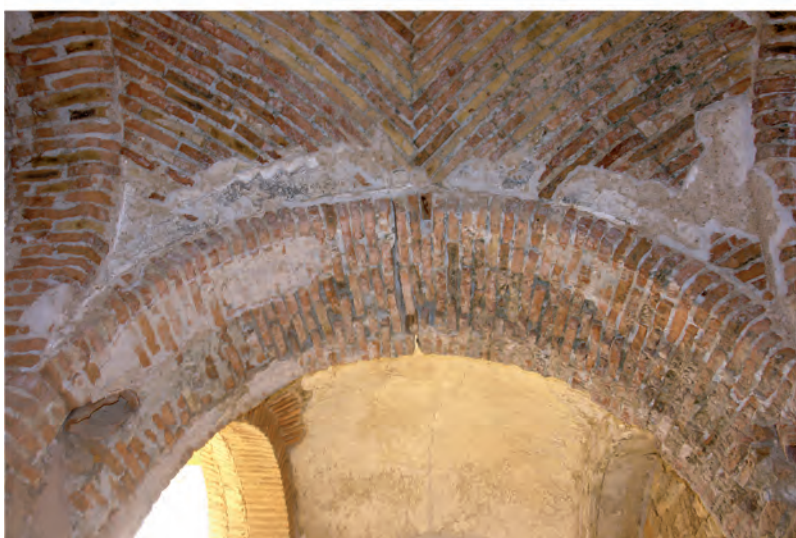
Abb. 10: Raum 31aO.M2, Rest der Stuckverzierung der Decke
