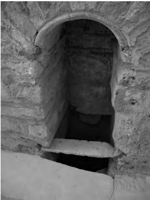
Abb. 13: Peristylhof 31aS, Tiefbrunnen 1 in der S-Mauer
