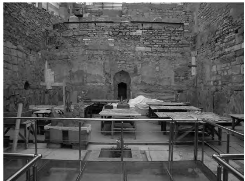
Abb. 50: Restaurierungsarbeiten im Marmorsaal 31 im Jahr 2005
