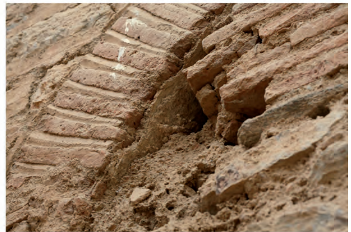
Abb. 2c: Mörtelbettung des Laibungsmosaiks
