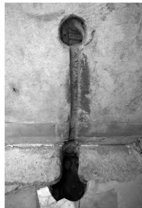
Abb. 37: Peristylhof 31a S-Umgang, Kanaleinlauf unterhalb Ausarbeitung für Wasserleitung
