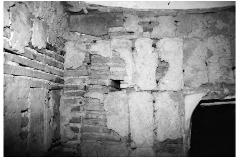
Abb. 28: Raum 8c, W-Wand mit Zugangsluke
