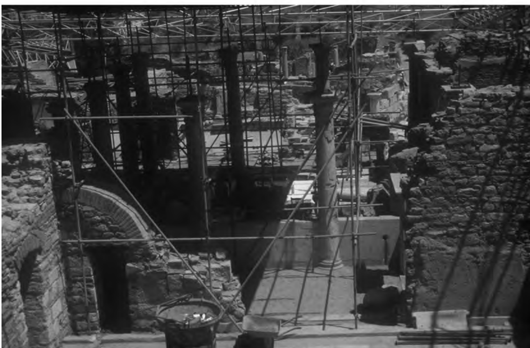
Abb. 46: Montage der Stahlkonstruktion des Schutzbaus im Jahr 2000
