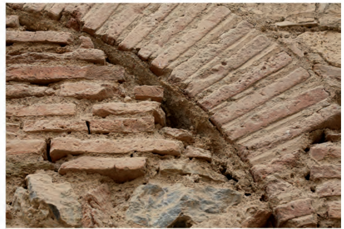
Abb. 2b: Mörtelbettung des Laibungsmosaiks
