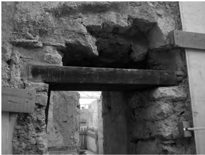
Abb. 17: Tür T 22 mit modern ergänztem Türsturz aus Holz
