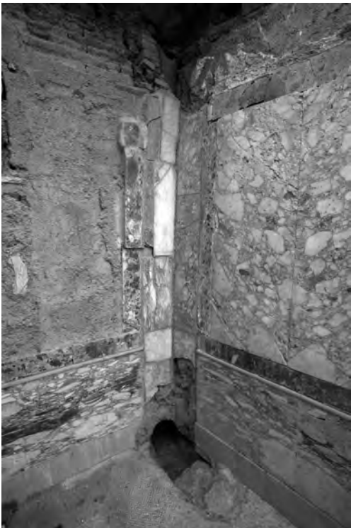
Abb. 11: Raum 36c, Fallrohr in NW-Ecke
