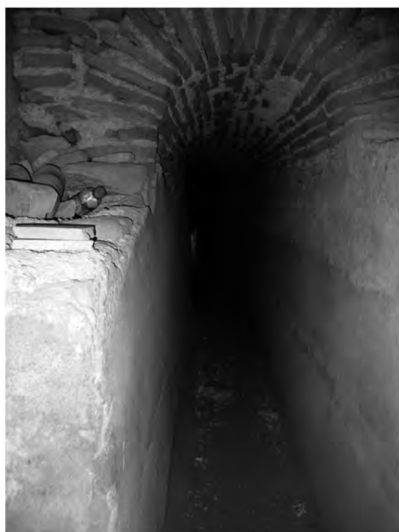
Abb. 16: Wasserkanal südlich Marmorsaal 31 (Aristion-Leitung)
