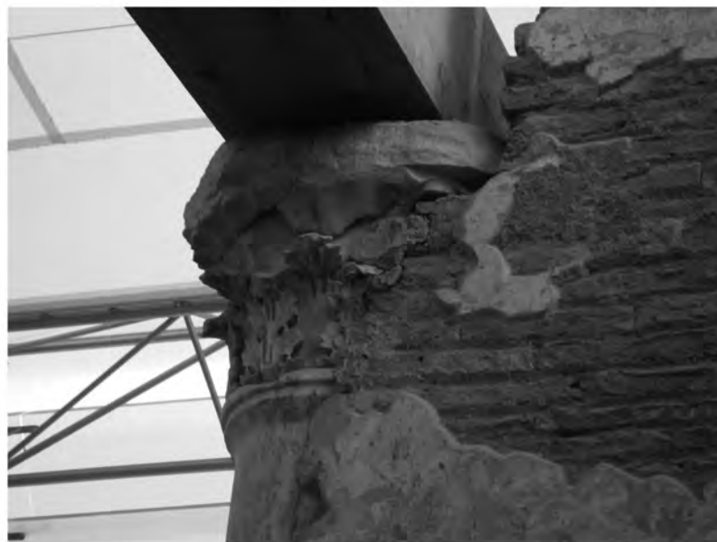
Abb. 7: Baderäume 31aO/M1 und 31aO/M2, Ziegelmauerwerk Typ 7
