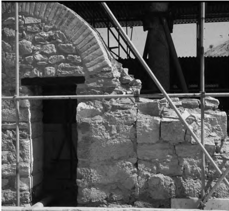
Abb. 1: Marmorsaal 31, N-Mauer mit Quadern aus Glimmerschiefer
