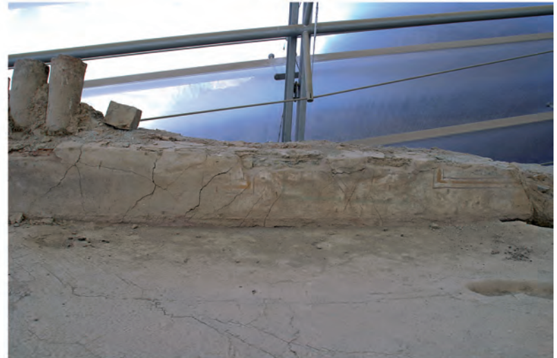
Abb. 52: OG Raum 31aO.1, O-Wand
