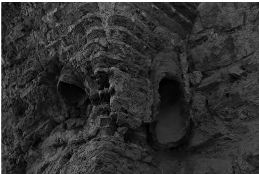
Abb. 4: Tonrohre als Rauchabzug im Bad 31aO
