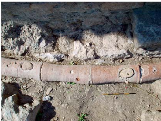
2 Cryptoporticus der Substruktionen. Leitungen im Nordosten
