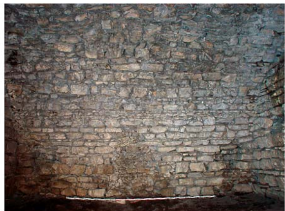
6 Substruktionen. Raum K nach Westen
