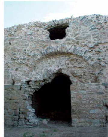
3 Nordansicht. Gesicherter Zugang zu Raum F
