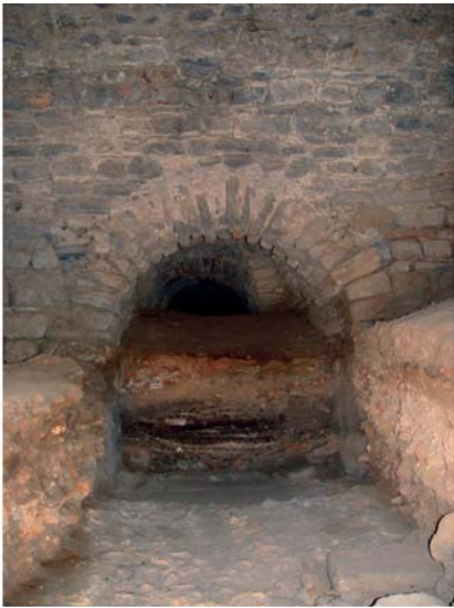
1 Substruktionen. Raum N nach Süden mit Zugang in den Korridor unter dem Wirtschaftshof
