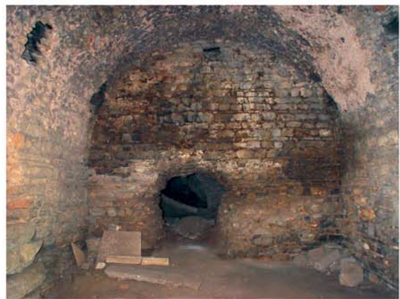
4 Substruktionen. Raum H nach Westen
