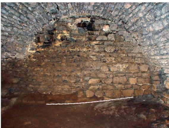
5 Substruktionen. Raum K Süden
