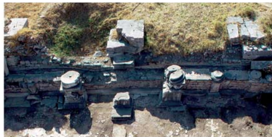
8 Marmorsaal. Hauptnische mit Altar und flankierenden Säulen (Kranbild)
