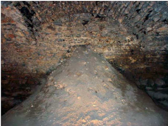
1 Substruktionen. Raum J nach Süden mit Versturzkegel aus Korridor L
