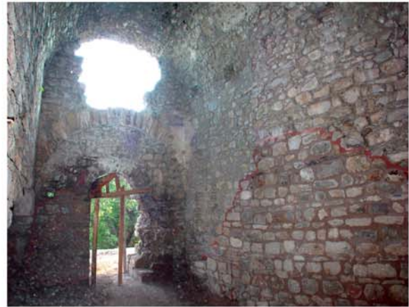
2 Nordansicht. Raum G nach der Sicherung
