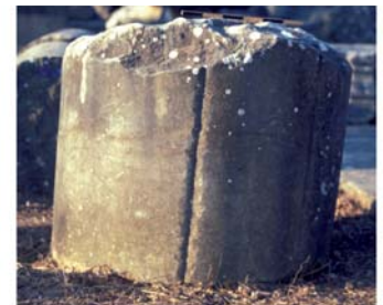
9 Marmorsaal. Fragment der Säule der Hauptnische mit vorbereiteten Rillen für die Steinsäge A 88
