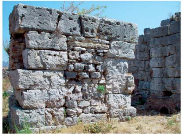
4 Caldariumsaal XVIII. Geschlossene Öffnung im Mittelpfeiler im Norden
