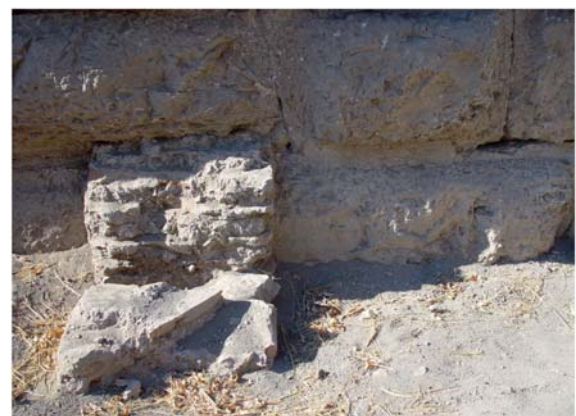
6 Substruktionen. Ziegelmaueranschluss am Bossenmauerwerk im Bereich vor Raum J
