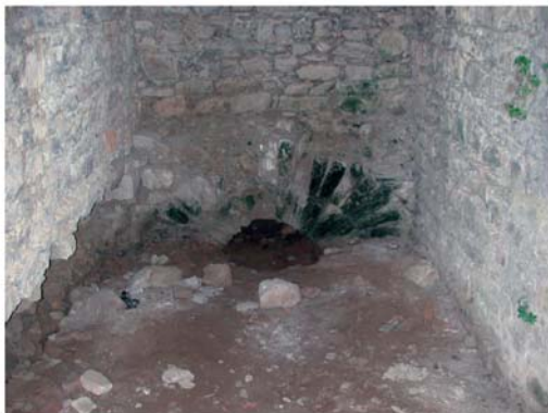
3 Substruktionen. Entwässerungskanal der Palästra in Raum C
