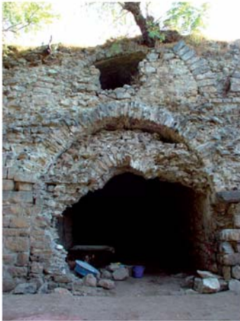
1 Nordansicht. Stark beraubter Zugang zu Raum F
