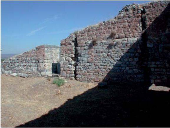
1 Tepidarium XIX. Nordwand mit den beiden Zügen für das Heizgas
