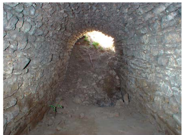
6 Substruktionen. Korridor L nach Westen
