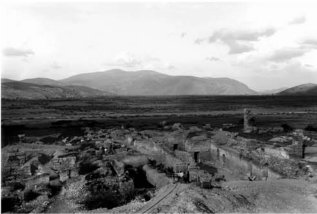
3 Freilegung der Räume VIII und IX (1928)
