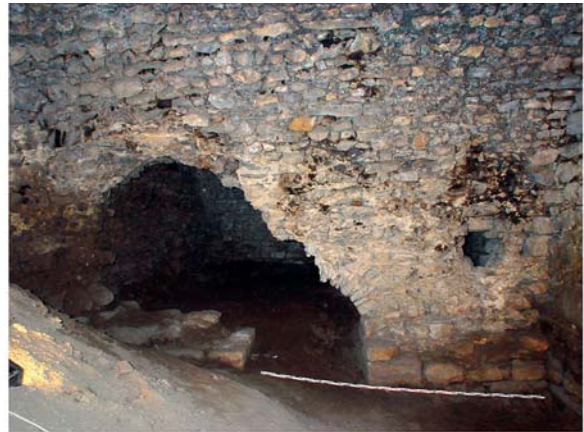
2 Substruktionen. Raum I nach Westen
