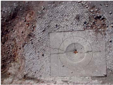
1 Bodeneinlauf in der Nordostecke von Raum XXI mit Mosaik MO 6
