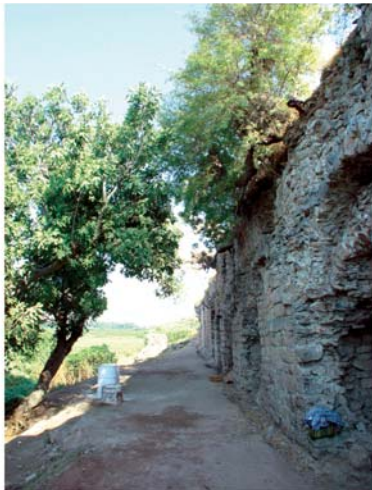
1 Nordfassade vor Rodung der Bäume in den Mauern
