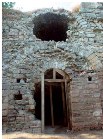
6-8 Nordansicht. Zugang zu Raum G
