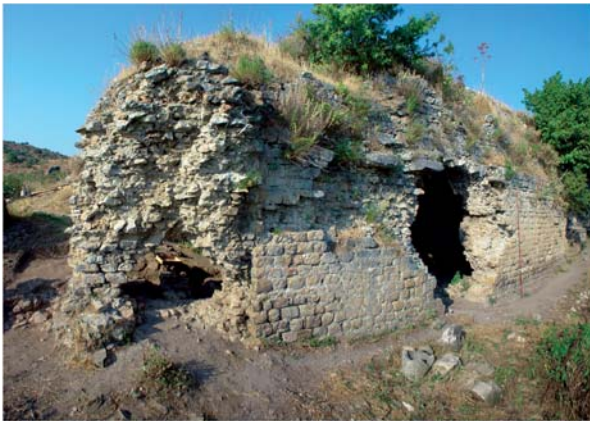
1 Substruktionen. Bauzeitliche Latrine Raum A. Nordostecke mit Resten des Auflagers der Treppe in das Thermengeschoss vor der Sicherung
