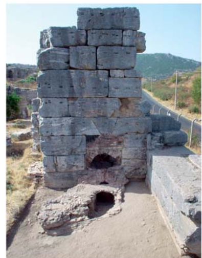
6 Caldariumhauptsaal XVII. Präfurnium für das südwestliche Becken im Pfeiler im Südwesten
