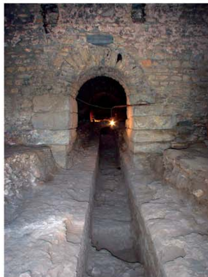
5 Substruktionen. Raum H nach Süden mit freigelegtem Hauptsammler
