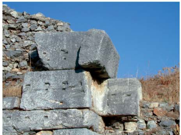
6 Situation im spiegelsymmetrischen Caldariumsaal XVI. Anfängerstein des die Nische überfangenden Bogens
