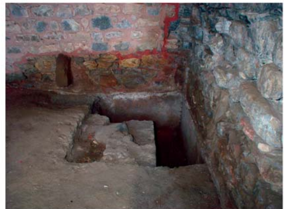
5 Substruktionen. Bauzeitliche Latrine Raum A. Nordwestecke innen mit geputztem Latrinenkanal und Konsolstein der Bank
