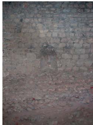
4 Substruktionen. Südwand mit Nische in Raum E
