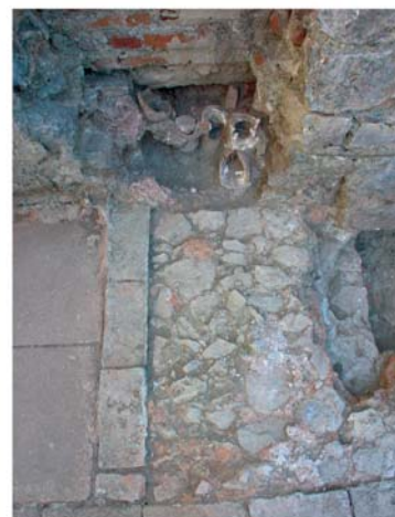
3 Flügelsaal IIIa. Becken in der nordwestlichen Nische, Leitungen
