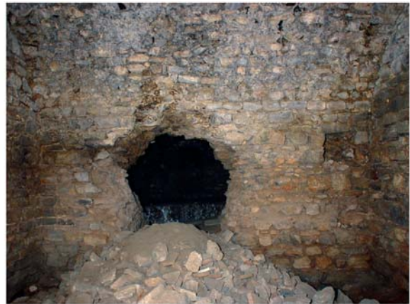
2 Substruktionen. Raum I nach Osten
