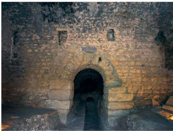
3 Substruktionen. Raum H nach Süden
