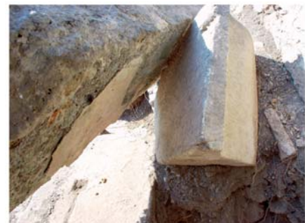
7 Marmorsaal. Pfeiler A 98 der unteren Ordnung in der Nordwestecke mit Putzrest auf der Rückseite (zweilagig), auf eine Konsole der Dachkonstruktion gestürzt
