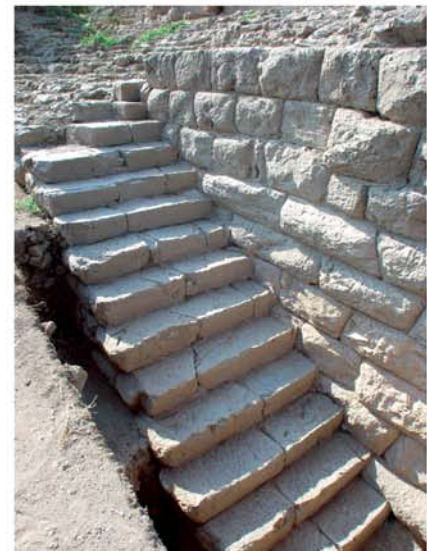
5 Substruktionen. Treppe aus Bossenquadern an der Nordostecke
