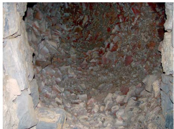
6 Substruktionen. Korridor unter dem Wirtschaftshof XII. Blick in die Versturzklammer über der Ladeöffnung in den Hof
