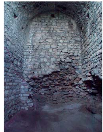
5 Substruktionen. Südwand in Raum F
