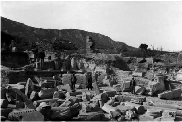
1 Freilegung des Marmorsaals (1927)
