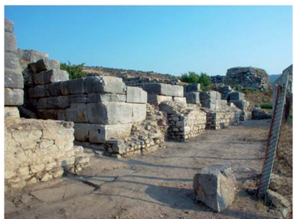
6 Tepidarium XIX. Vorgelagerter Heizgang im Westen mit Ansatz der Einwölbung
