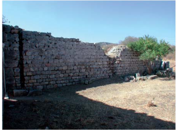
2 Tepidarium XIX. Südwand mit den beiden Zügen für das Heizgas
