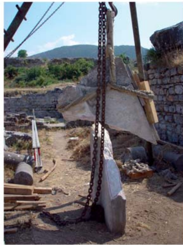
1-3 Kleben und Aufstellen der Türgewände A 77 zu Raum II
