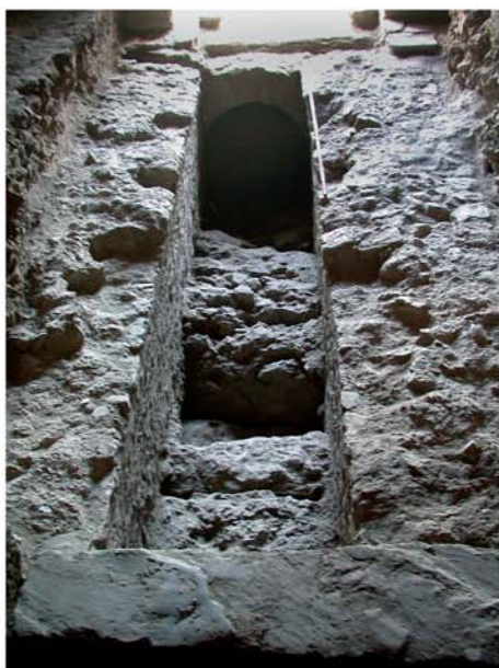
1 Schnitt 3/02. Raum H. Abwasserkanal von Süden
