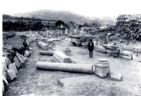
2 Peristyl der Palästra von Norden mit Basenpostament in der Nordwestecke in situ und Architekturproben des Marmorsaals. Historisches Grabungsfoto
