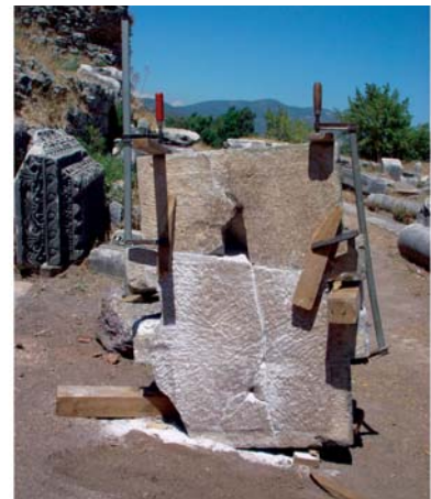
4 Marmorsaal. Kleben der nördlichen Doppelhalbsäulenpfeilerbasis A 89
