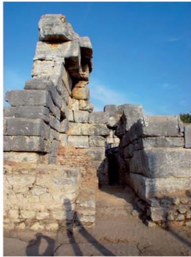
1–3 Caldariumhauptsaal XVII. Gewölbepfeiler im Südwesten. Scheingewölbe zur Aufnahme von Präfurnien
