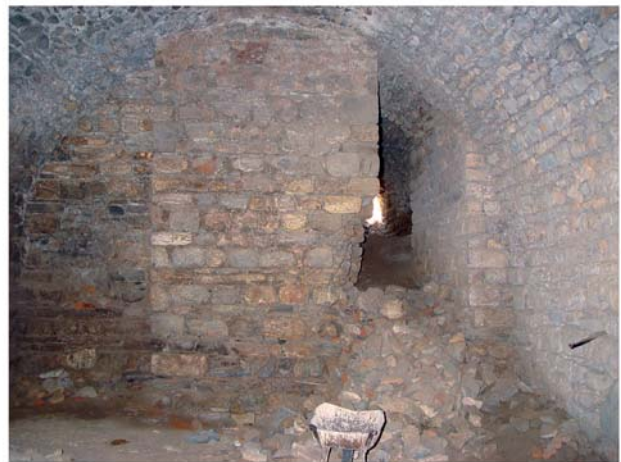
4 Substruktionen. Raum H nach Westen mit Zugang in den Korridor L
