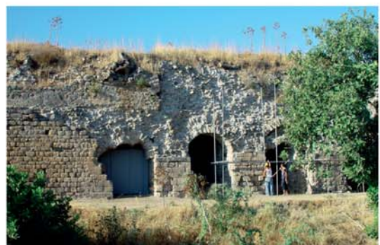
6 Nordfassade. Sicherung der Fassade
