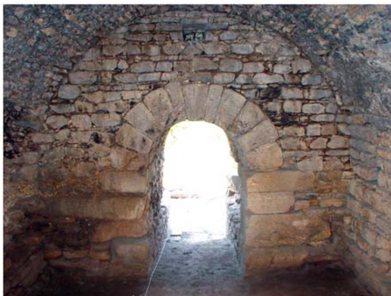
5 Substruktionen. Raum J nach Norden
