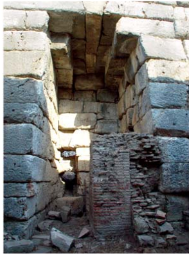
2 Wirtschaftshof X. Scheingewölbe im südöstlichen Pfeiler des Caldariumsaals XVII zur Aufnahme von Präfurnien
