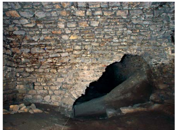
4 Substruktionen. Raum K nach Osten
