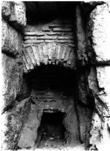
4 Wirtschaftshof X. Präfurnium für das südliche Becken im Caldariumhauptsaal XVII mit heute verlorenem Tonrohr. Historisches Grabungsfoto
