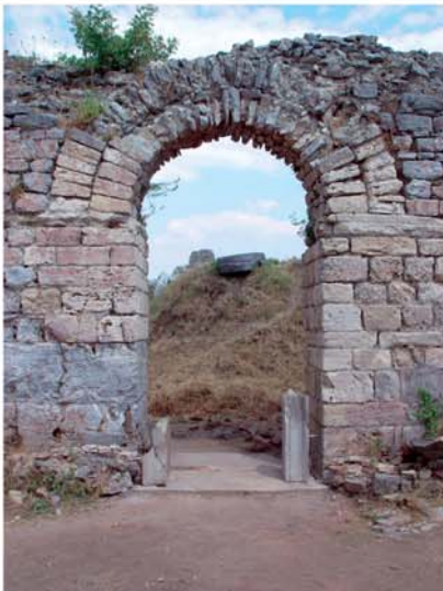
5 Apodyterium VI. Nördliche Tür in den Flügelsaal IIIa
