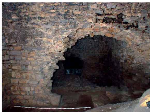
6 Substruktionen. Raum J nach Osten
