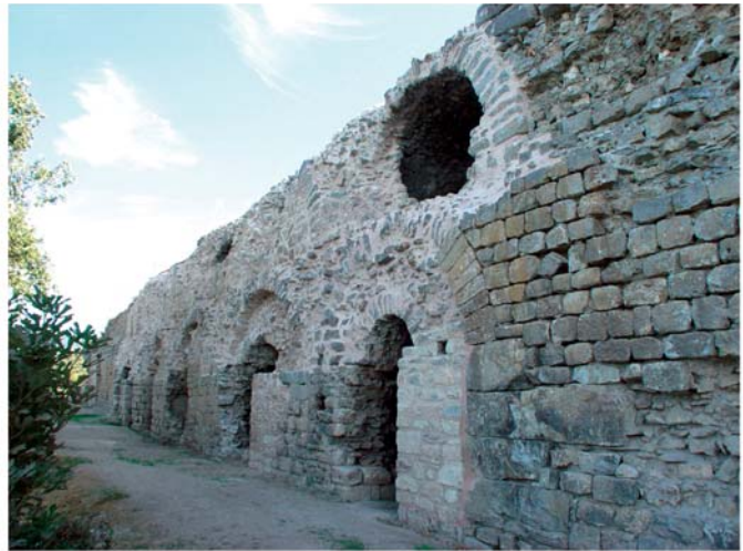
2 Nordfassade nach der Rodung und Sicherung
