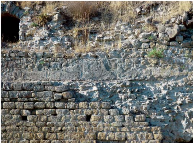
4 Nordansicht. Außenwandbefund zwischen Raum A und B mit Putzquadern
