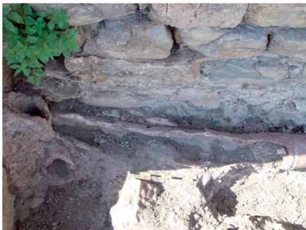
4 Substruktionen. Rohr aus dem Schnitt an der Treppe (StreuFund)
