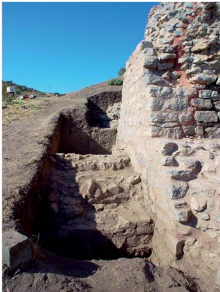
3 Substruktionen. Bauzeitliche Latrine Raum A. Anschluss des Hauptsammlers
