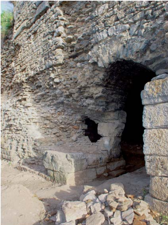
1 Substruktionen. Zugang in Raum H nach Osten vor der Sicherung
