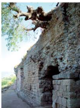
5 Vediusgymnasium Nordansicht nach der Beseitigung des Abraumkegels der 1920er Jahre
