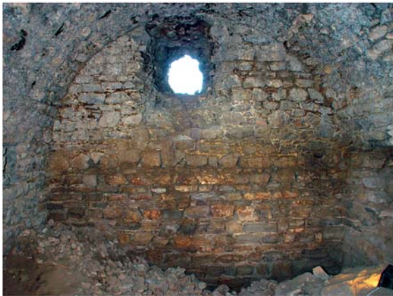
1 Substruktionen. Raum I nach Norden
