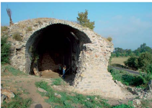
5 Substruktionen. Bauzeitliche Latrine Raum A von Osten mit gesicherter Nordostecke
