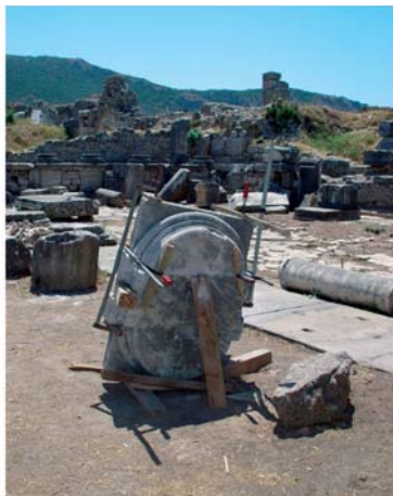
2 Marmorsaal. Kleben der nördlichen Doppelhalbsäulenpfeilerbasis A 89
