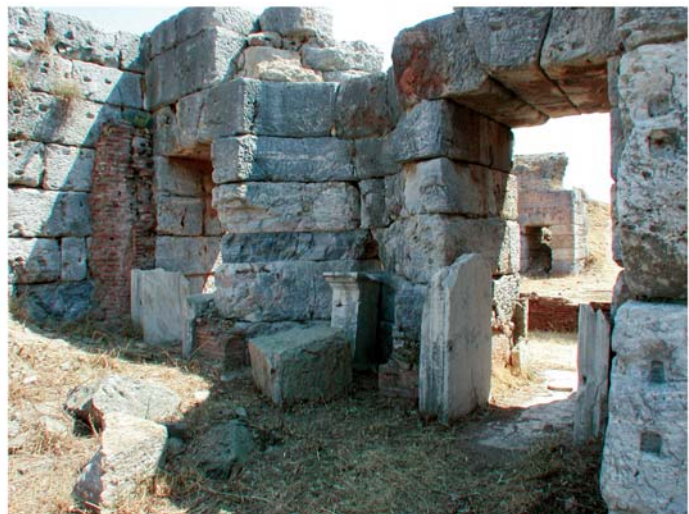
4 Caldariumhauptsaal XVII. Halbrunde Nische in der Ostwand
