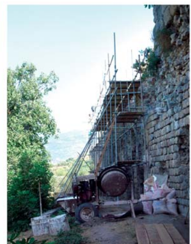
7 Nordfassade nach der Rodung während der Sicherung
