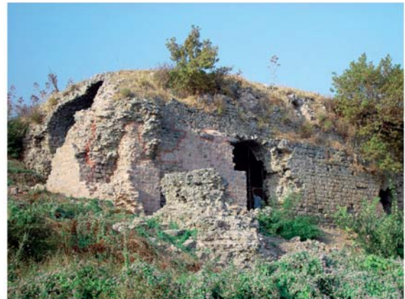
2 Substruktionen. Bauzeitliche Latrine Raum A. Nordostecke mit Resten des Auflagers der Treppe in das Thermengeschoss nach der Sicherung
