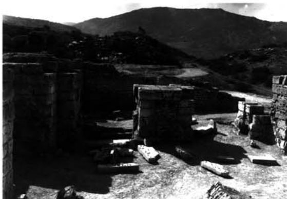
3 Caldariumhauptsaal XVII. Situation nach der Grabung nach Süden. Historisches Grabungsfoto
