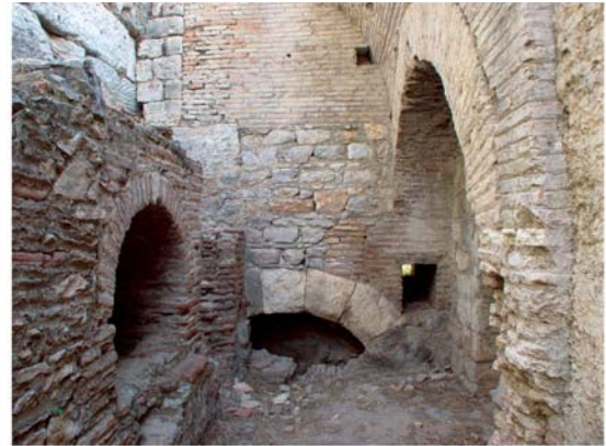
5 Wirtschaftshof X. Nordwand mit Öffnung in die Substruktionen und sekundärem Präfurnium im Osten
