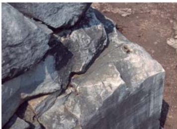
4 Marmorsaal. Nördliche Basis der Hauptnische mit antiker Klammerung
