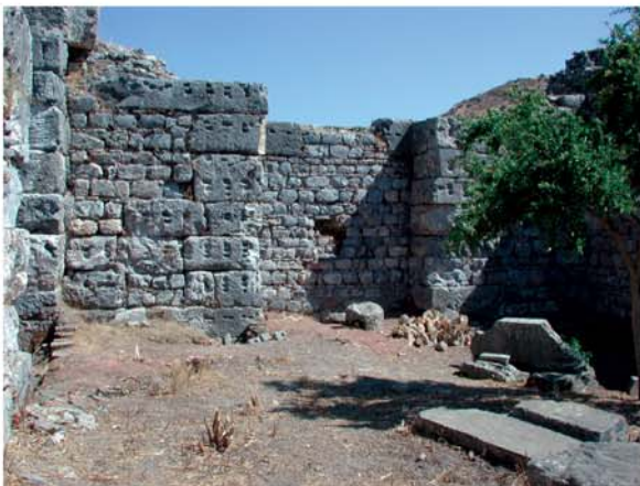
5 Caldariumsaal XVIII. Ostwand mit Basis des Labrums und Öffnung für die Versorgungsleitung
