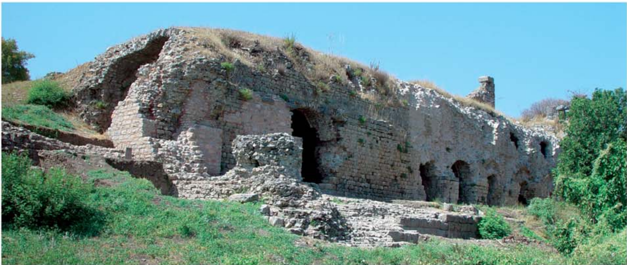
3 Nordansicht. Östlicher Bereich nach Rodung und Sicherung
