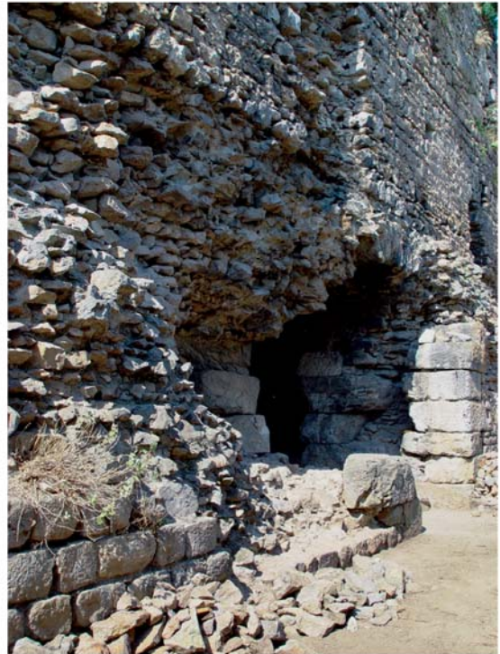
2 Substruktionen. Zugang in Raum H nach Westen vor der Sicherung
