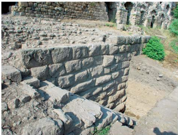
2 Substruktionen. Treppe aus Bossenquadern an der Nordostecke
