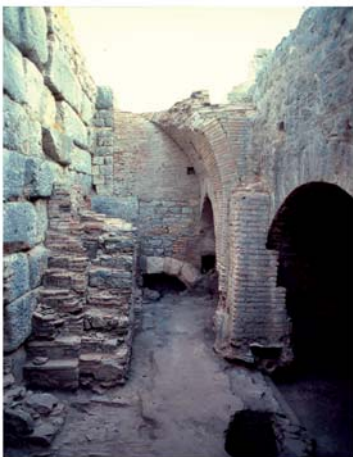
6 Wirtschaftshof X nach Norden mit dreiphasiger Kesseltreppe an der Westwand und Gewölbe des Freispiegelbeckens im Osten
