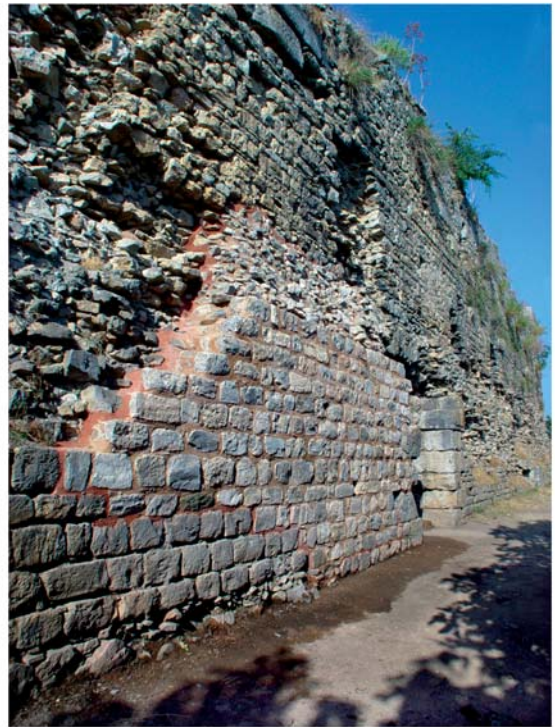
4 Substruktionen. Zugang in Raum H nach Westen nach der Sicherung
