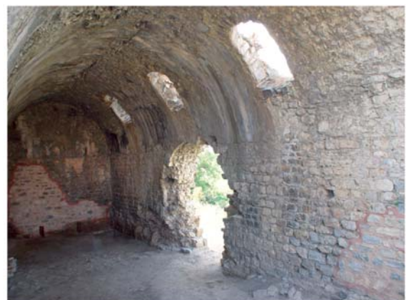
6 Substruktionen. Bauzeitliche Latrine Raum A nach Westen nach der Sicherung
