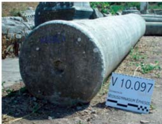
1 Palästra. Säulenfragment mit antikem Reparaturdübelloch
