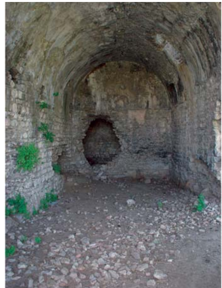
4 Substruktionen. Bauzeitliche Latrine Raum A nach Westen vor der Sicherung
