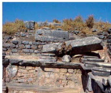
6 Marmorsaal. Pfeiler A 98 der unteren Ordnung in der Nordwestecke, auf eine Konsole der Dachkonstruktion gestürzt
