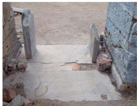
5 Flügelsaal IIIa. Aufgestellte und fixierte Türgewände der nördlichen Tür in das Apodyterium VI
