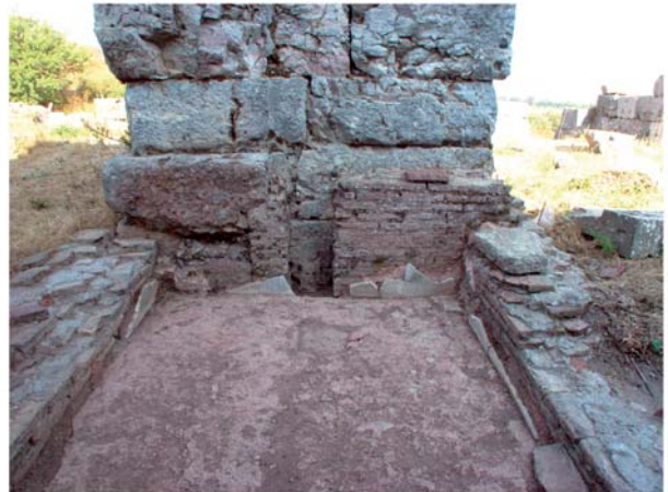
3 Caldariumhauptsaal XVII. Becken im Süden nach Westen mit zentralem Schacht an der Westwand für das Heizgas
