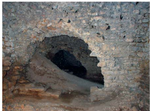
4 Substruktionen. Raum I nach Westen
