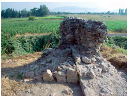
4 Substruktionen. Opus caementicium -Kern der Treppe in das Thermengeschoss
