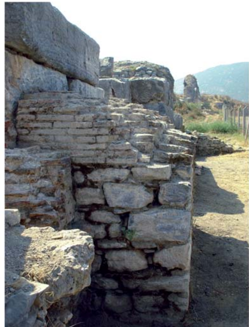
2 Caldariumsaal XVIII. Reste der Einwölbung des Heizgangs zwischen den Präfurnien
