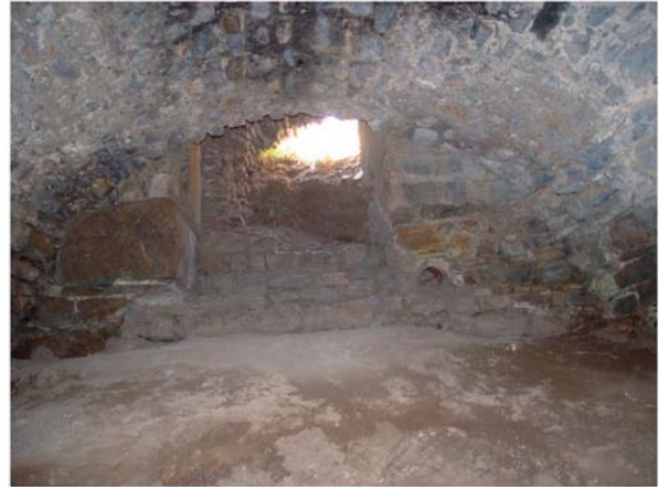
2 Substruktionen. Raum N nach Westen mit Zugang zum Präfurnium für Caldariumsaal XVI
