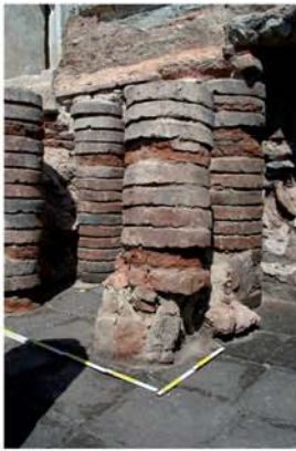
1 Schnitt 1/04. Reparaturen an pilae
