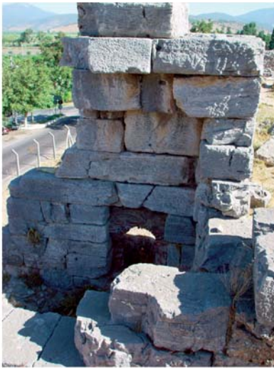
1–3 Caldariumhauptsaal XVII. Gewölbepfeiler im Südwesten. Scheingewölbe zur Aufnahme von Präfurnien
