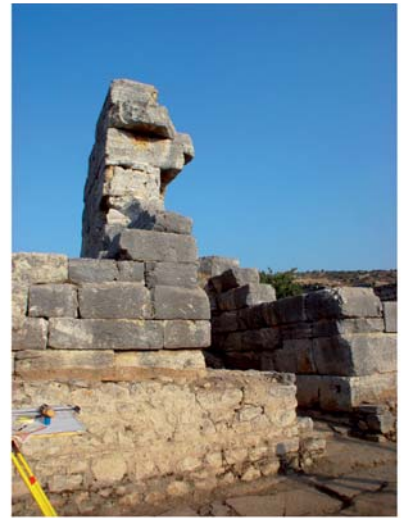
1–3 Caldariumhauptsaal XVII. Gewölbepfeiler im Südwesten. Scheingewölbe zur Aufnahme von Präfurnien
