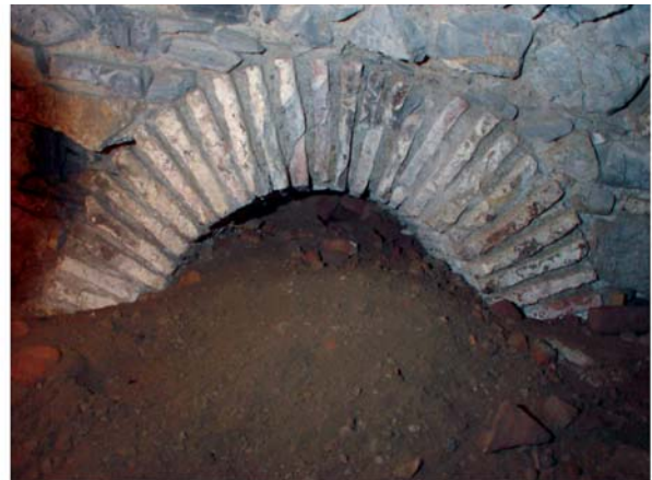
4 Substruktionen. Korridor unter dem Wirtschaftshof XII. Abzweig auf die Treppe in den Hof
