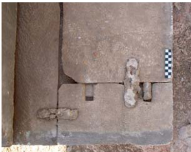
7 Marmorsaal. Nordwestecke des Altars mit funktionslosen Klammerlöchern
