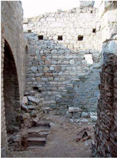
1 Wirtschaftshof X. Treppen an der Südseite. Im Vordergrund die Austrittssituation der Treppe aus den Substruktionen
