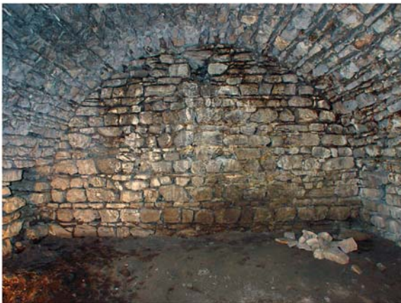
3 Substruktionen. Raum K nach Norden
