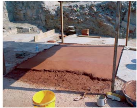
3 Flügelsaal IIIb. Abdecken des bauzeitlichen Mosaiks MO 3
