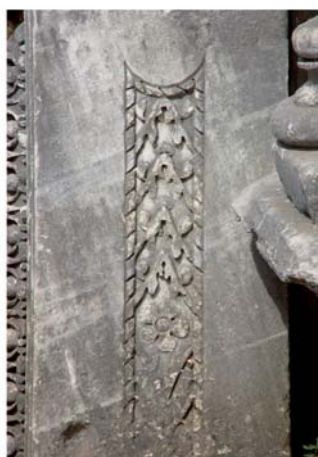
6 Marmorsaal. Architrav der Nordseite A 118. Detail Soffitte
