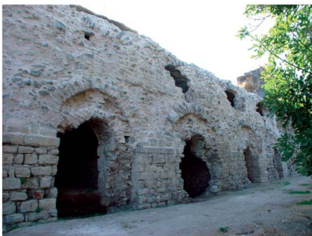
6 Nordfassade nach der Rodung und Sicherung
