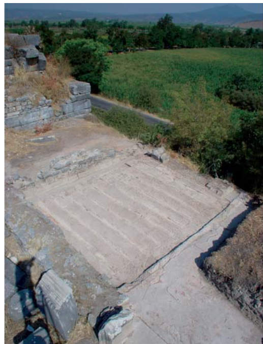
7 Palästra. Flachdacheinbau in Raum XXII
