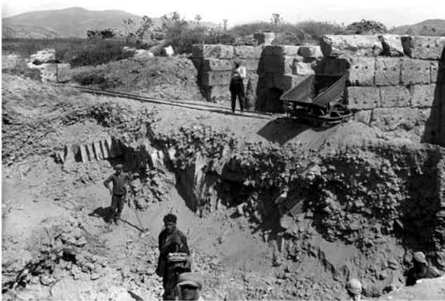
3 Freilegung des Caldariums (Raum XVII, 1929)
