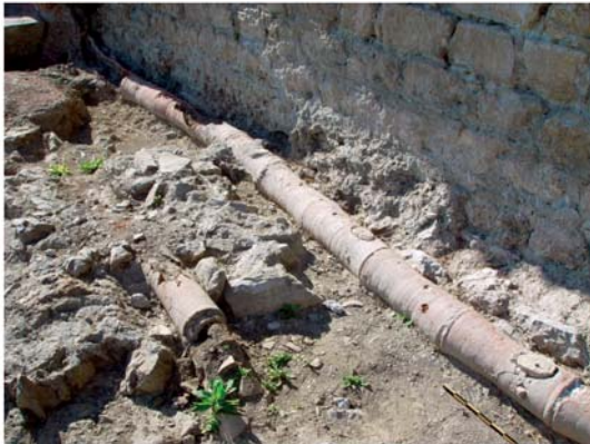
1 Cryptoporticus der Substruktionen. Leitungen in der Nordostecke
