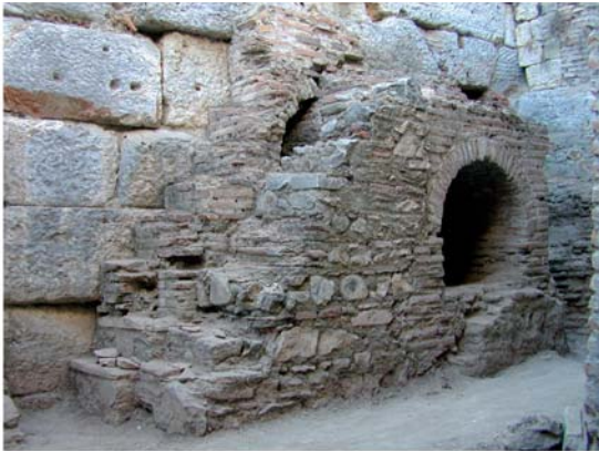
4 Wirtschaftshof X. Dreiphasige Kesseltreppe an der Westwand
