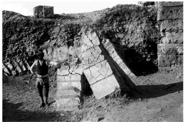
4 Gewölbeeckelemente in Sturzlage (Raum XVII, 1929)
