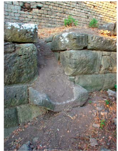
5 Substruktionen. Wasserspeier des Entwässerungskanal der Natatio
