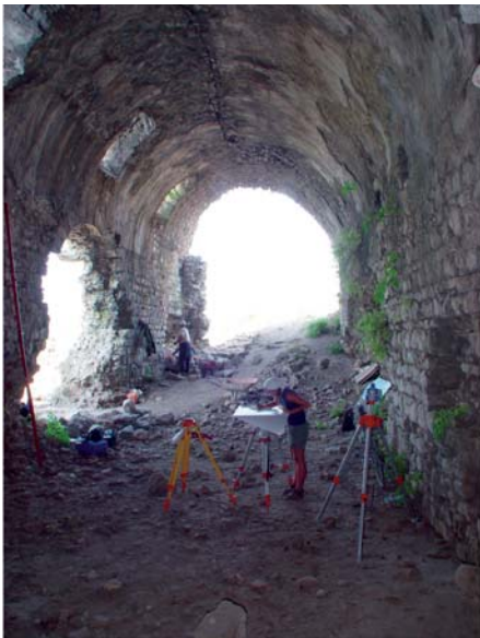
3 Substruktionen. Bauzeitliche Latrine Raum A nach Osten
