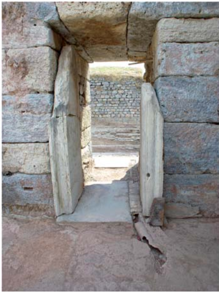
1 Zentralraum V. Südliche Tür in die Natatio IV mit Leitungseinbau in der Schwelle
