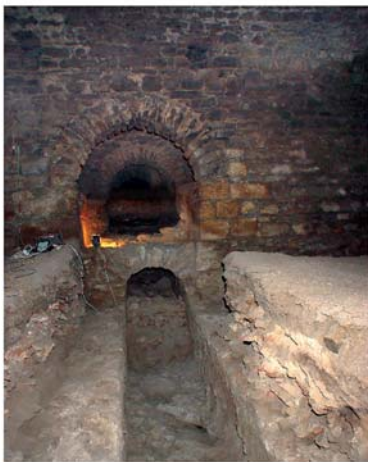
3 Substruktionen. Raum M nach Süden mit freigelegtem Hauptsammler
