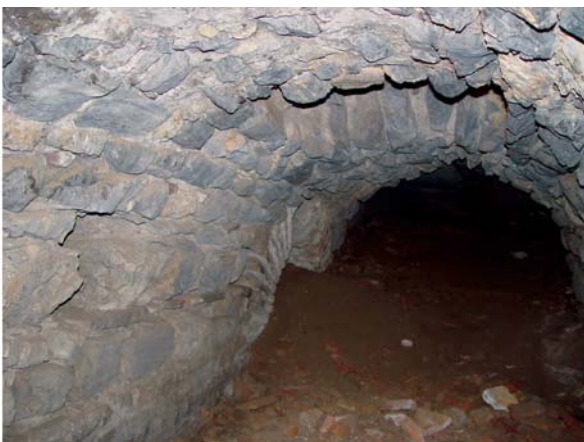
5 Substruktionen. Korridor unter dem Wirtschaftshof XII. Ladeöffnung
