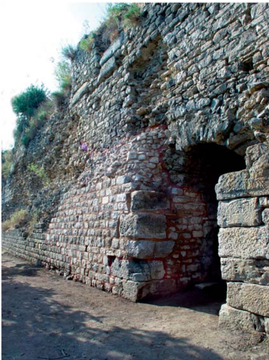
3 Substruktionen. Zugang in Raum H nach Osten nach der Sicherung
