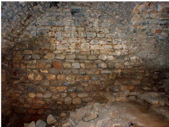
3 Substruktionen. Raum I nach Süden
