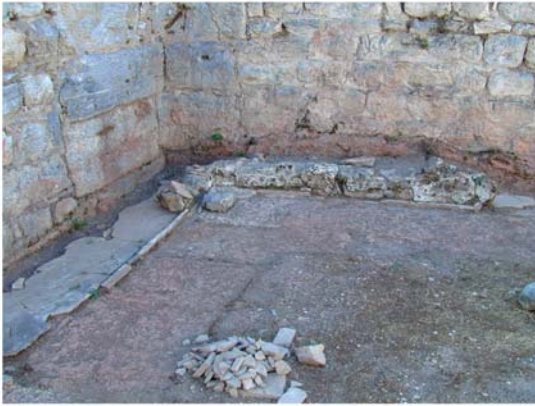
1 Raum VIII. Südostecke mit Stellstreifen, der den Bereich einer später massiv ausgeführten Bank begrenzt
