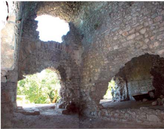
1 Nordansicht. Raum G mit beraubter Wand zu Raum F
