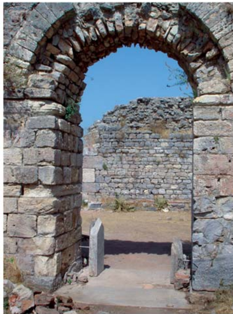
2 Flügelsaal IIIa. Nördliche Tür in das Apodyterium VI mit wiederaufgestellten Türgewänden
