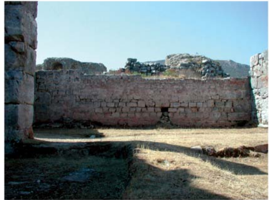
2 Raum VIII. Durchbruch für die sekundäre Versorgungsleitung in der Südwand, die in den Wirtschaftshof X führt
