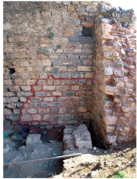
2 Substruktionen. Bauzeitliche Latrine Raum A. Nordostecke innen nach der Sicherung
