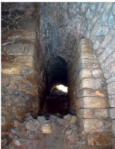
5 Substruktionen. Raum H nach Westen. Zugang in den Korridor L
