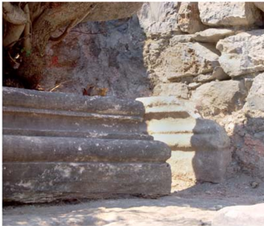
1 Marmorsaal. Pfeilerbasis der unteren Ordnung in der Südwestecke in situ mit Klammerlöchern auf der Seitenfläche. Basis auf der Rückseite in Bosse und Putzreste auf dem Pfeiler
