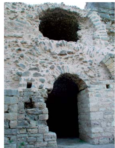
5 Nordansicht. Außenwandbefund zwischen Raum A und B mit Putzquadern (Detail)
