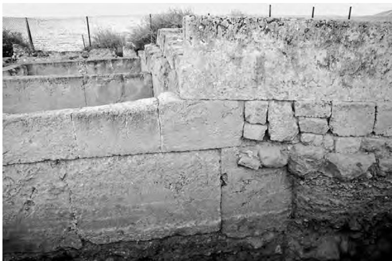
9 Oststraße. Nördlicher Orthostatenverband am Ende der Ostwand des Südbaus
