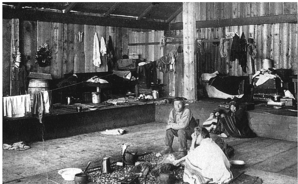
Abb. 49: Tlingit-Indianer in Sitka, Alaska (nach WYATT 1999, 156). Gut erkennbar ist der erhöhte, randliche Ruhebereich.
