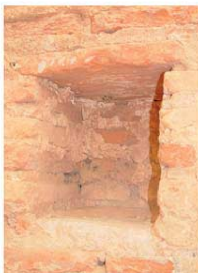
88.12: SR 9, Nische in W-Wand
