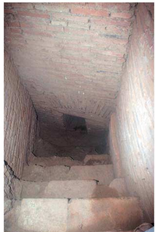
130.4: Treppe in Raum 22, unterer Lauf
