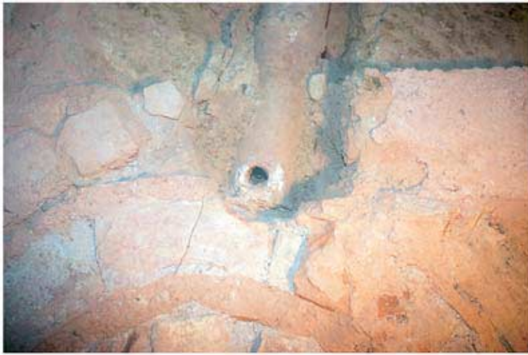
125.1: Hof 21, Tonrohrleitung mit ausgeschnittenem Loch für Bleirohrzuleitung
