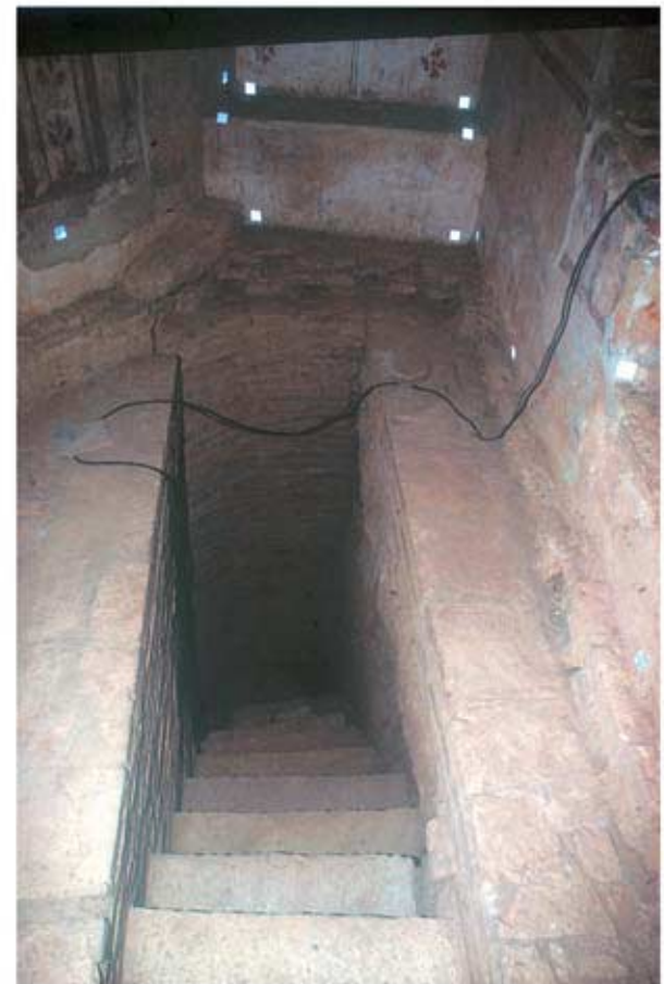
130.2: Treppe in Raum 22, oberer Lauf
