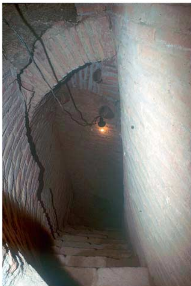
130.3: Treppe in Raum 22, unterer Lauf
