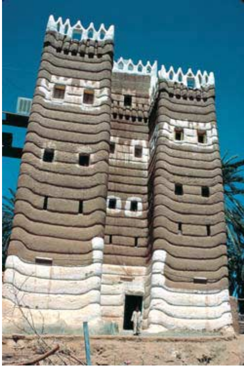
Abb. 83: „Zwischenschacht“-Gebäude in Lehm- wulsttechnik, Qarisha, W. Najrān
