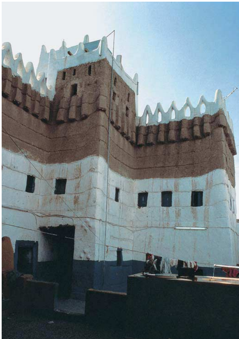
Abb. 85: Prestigebau in Adobe-Technik (Bayt Nasser ibn Hussayn), Najrān
