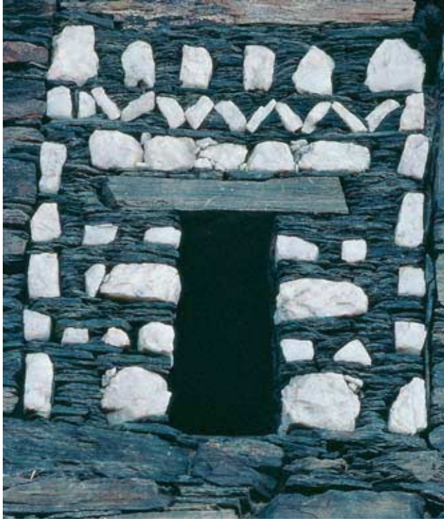
Abb. 97: Rahmendekor mit Dach- elementen, Sabaḥ Ballaḥmar
