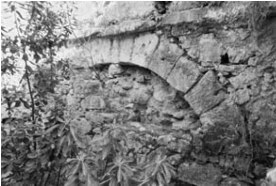
Abb. 32: Therme I.2, Raum C, Südwand
