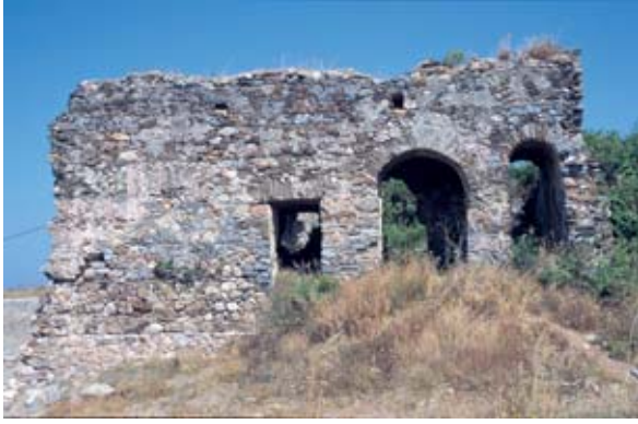
Abb. 42: Mauerwerk Typ e), Therme Aunesis, Ostfassade
