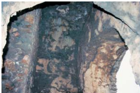
Abb. 37: Therme Aunesis, Gewölbe in Schleuse F
