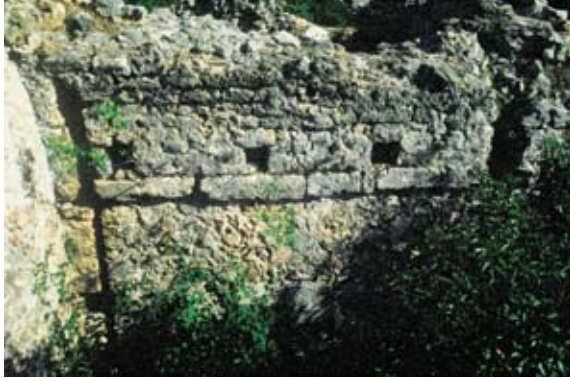
Abb. 30: Therme I.2, Raum C, Nordwand
