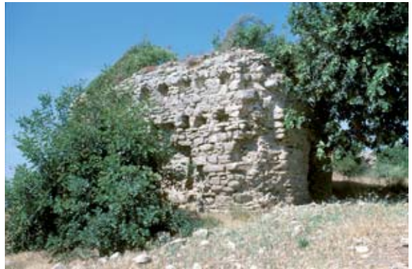
Abb. 41: Mauerwerk Typ d), Therme Kislabelen
