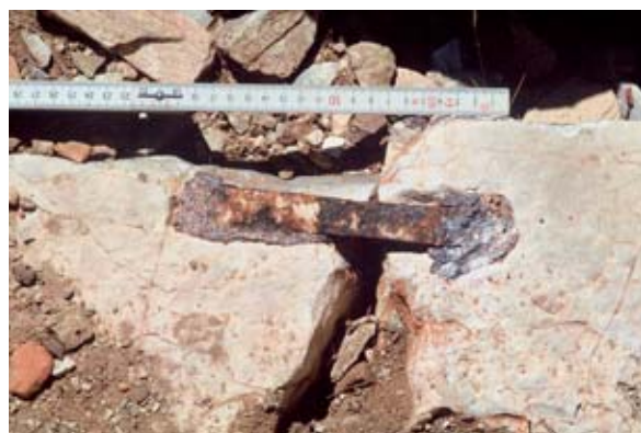
Abb. 20: I.6, Eisenklammer mit Bleiverguß
