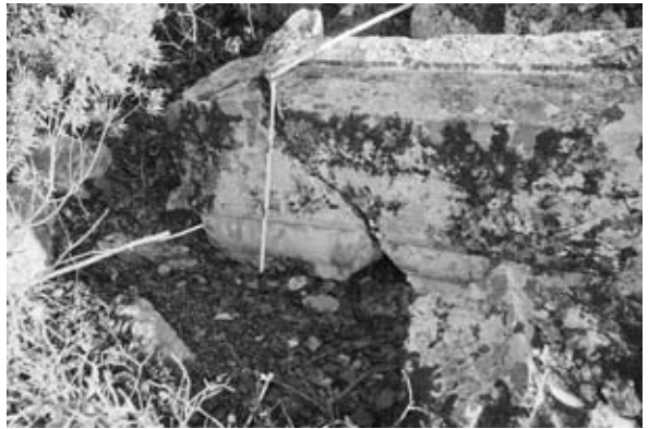
Abb. 15: II.21, Architrav, gestürzt
