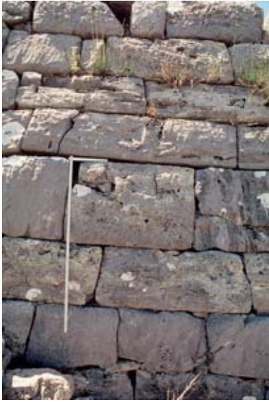
Abb. 38: Mauerwerk Typ a), Stadtmauer II.10
