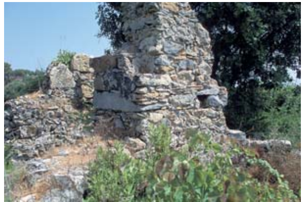
Abb. 45: Mauerwerk Typ h), Baptisterium Aunesis
