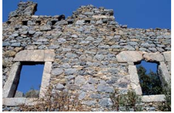
Abb. 44: Mauerwerk Typ g), Wohnhaus III.20
