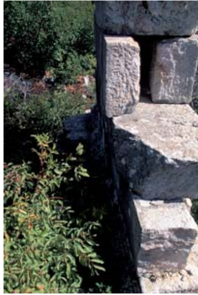
Abb. 40: Mauerwerk Typ c), Sitz III.19
