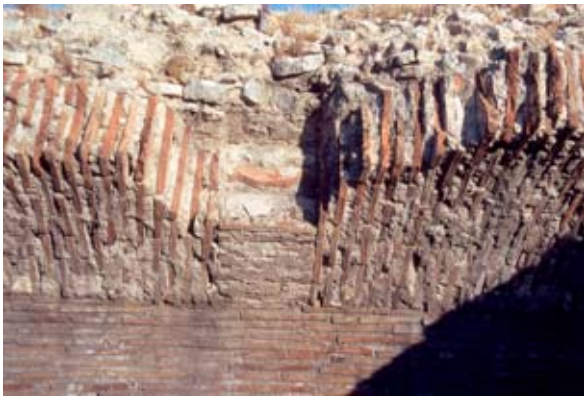
Abb. 43: Mauerwerk Typ f), Zisterne B6, Rhodiapolis
