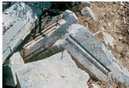
Abb. 5: A.3 Kirche, Mitteltüre, Sturz
