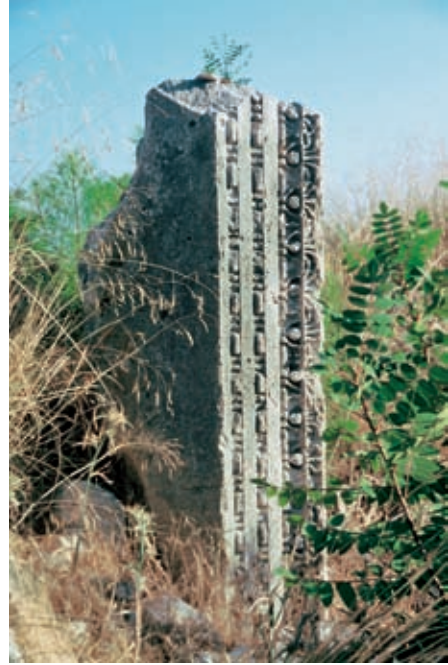
Abb. 23: B.6 Türgewände in situ
