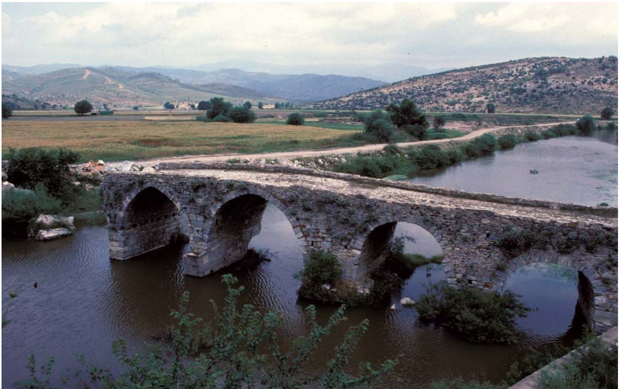
26 Römische Brücke über den Sarı Çay (Keniös), 6 km nw. von Mylasa (1991)
