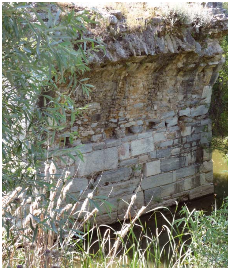
28 Brücke über den Sarı Çay (Keniös) 2008
