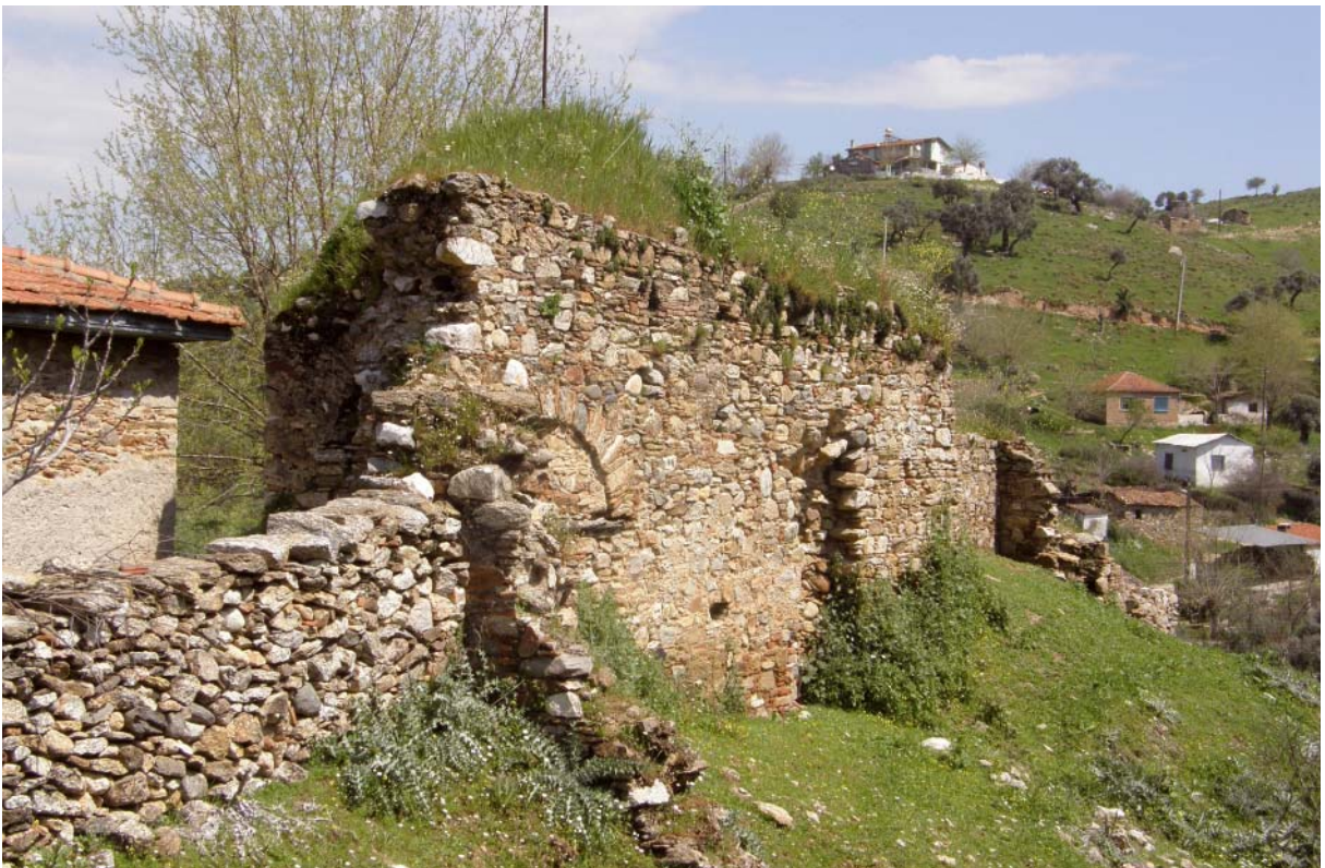
18 Mauerabschnitt der Cincin Kalesi aus spätbyzantinischer Zeit
