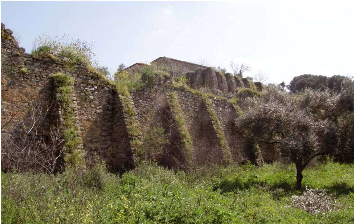
17 Stützmauern mit abgeschrägten Pfeilern der Cincin Kalesi
