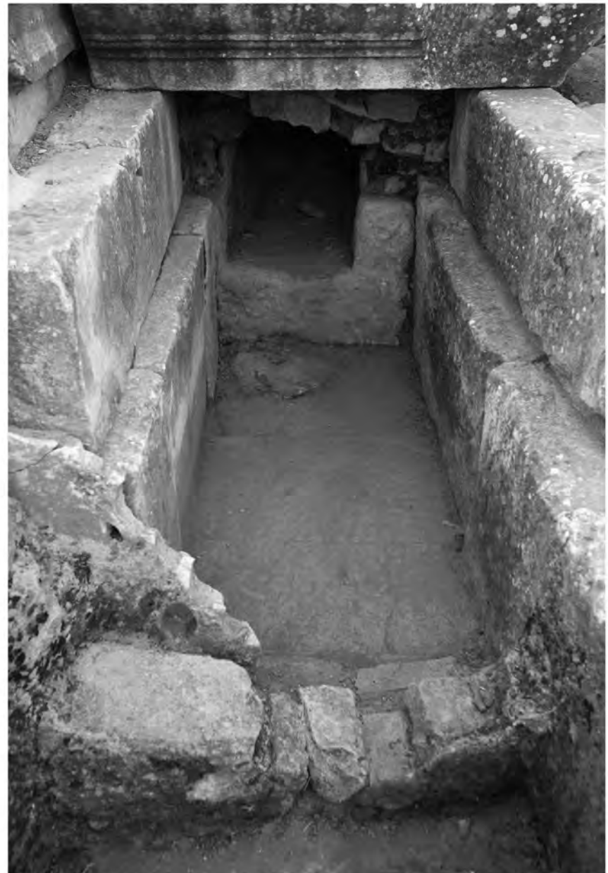
3 Abfluß an der Ostseite
