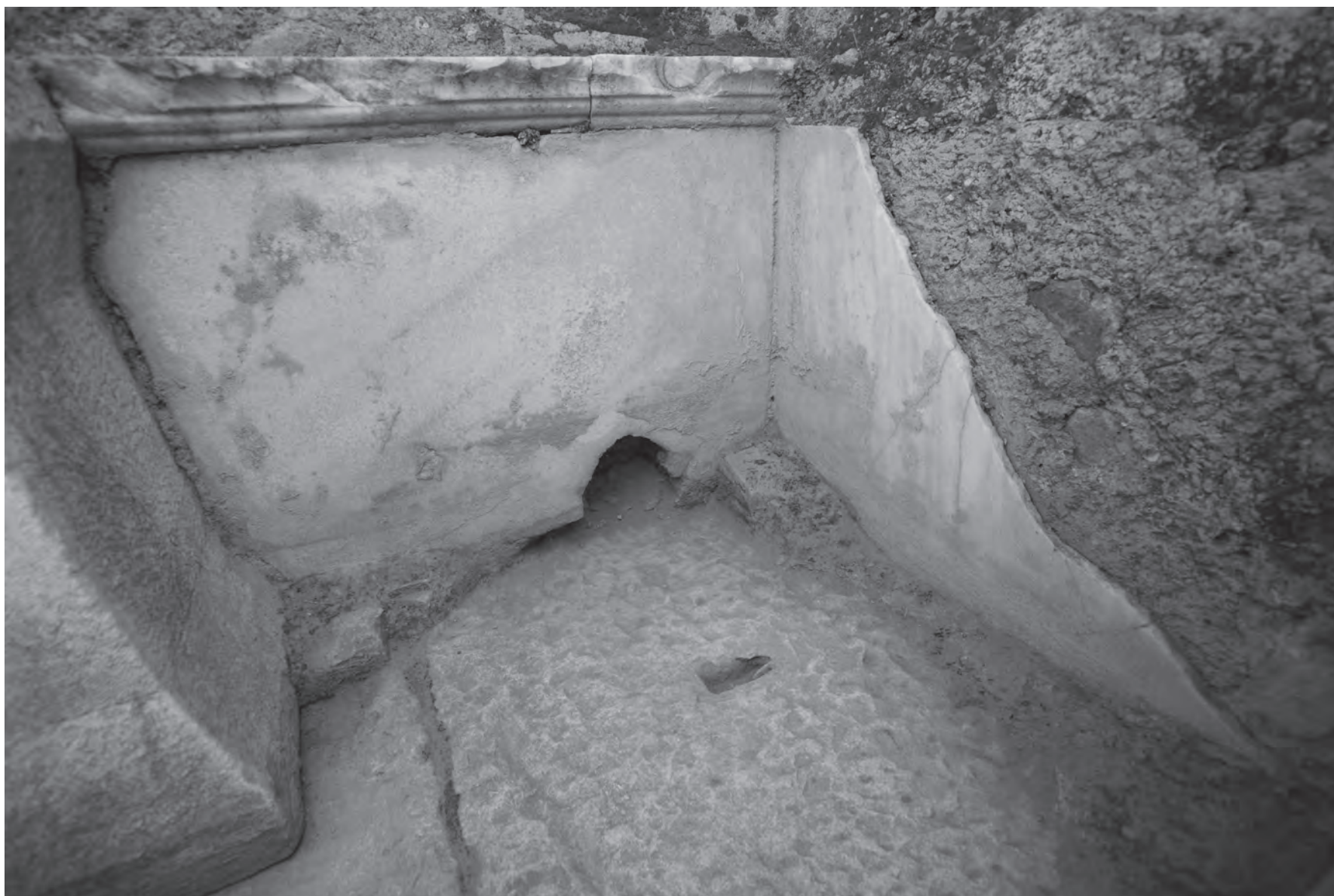
1 NO-Ecke der Rückwand an der Innenseite mit Wandverkleidung
