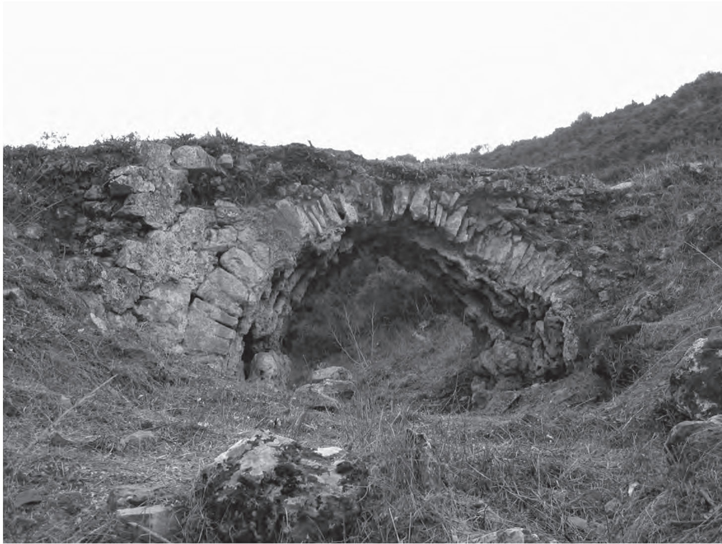
1 Sog. 5. Kurudere-Aquäduktbrücke der Aristion-Leitung
