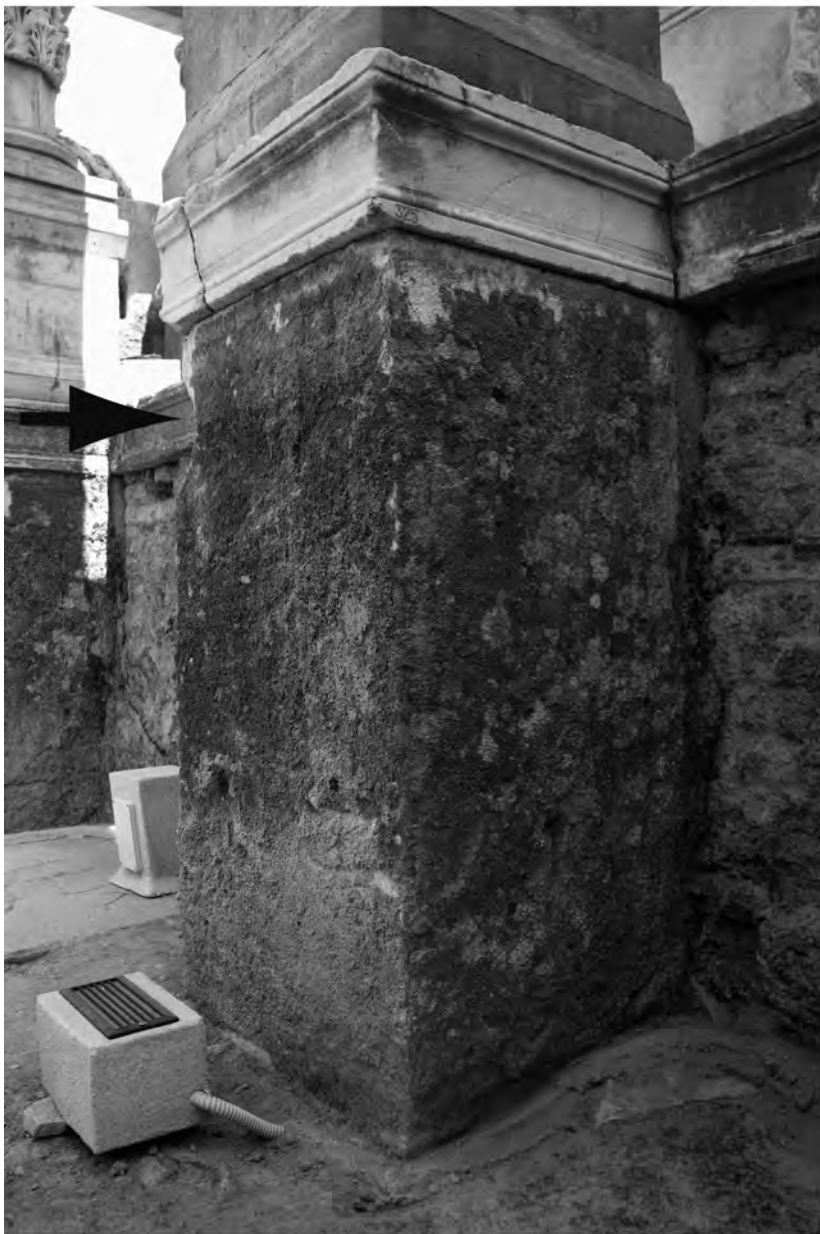
2 Marmorquader der Rückwand, an dem sich der Wasserstand ablesen lässt
