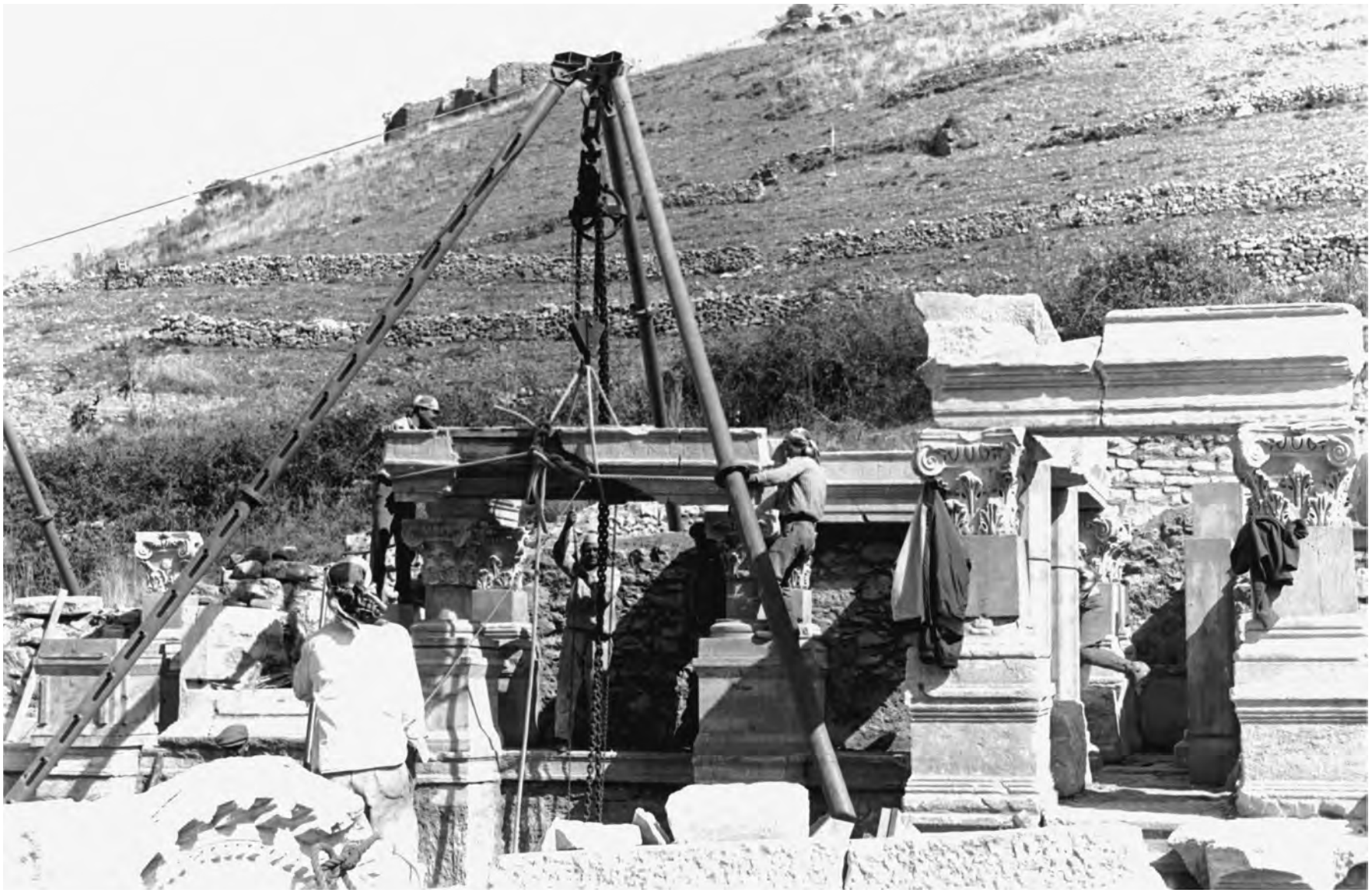
1 Aufstellen der Architekturprobe 1962
