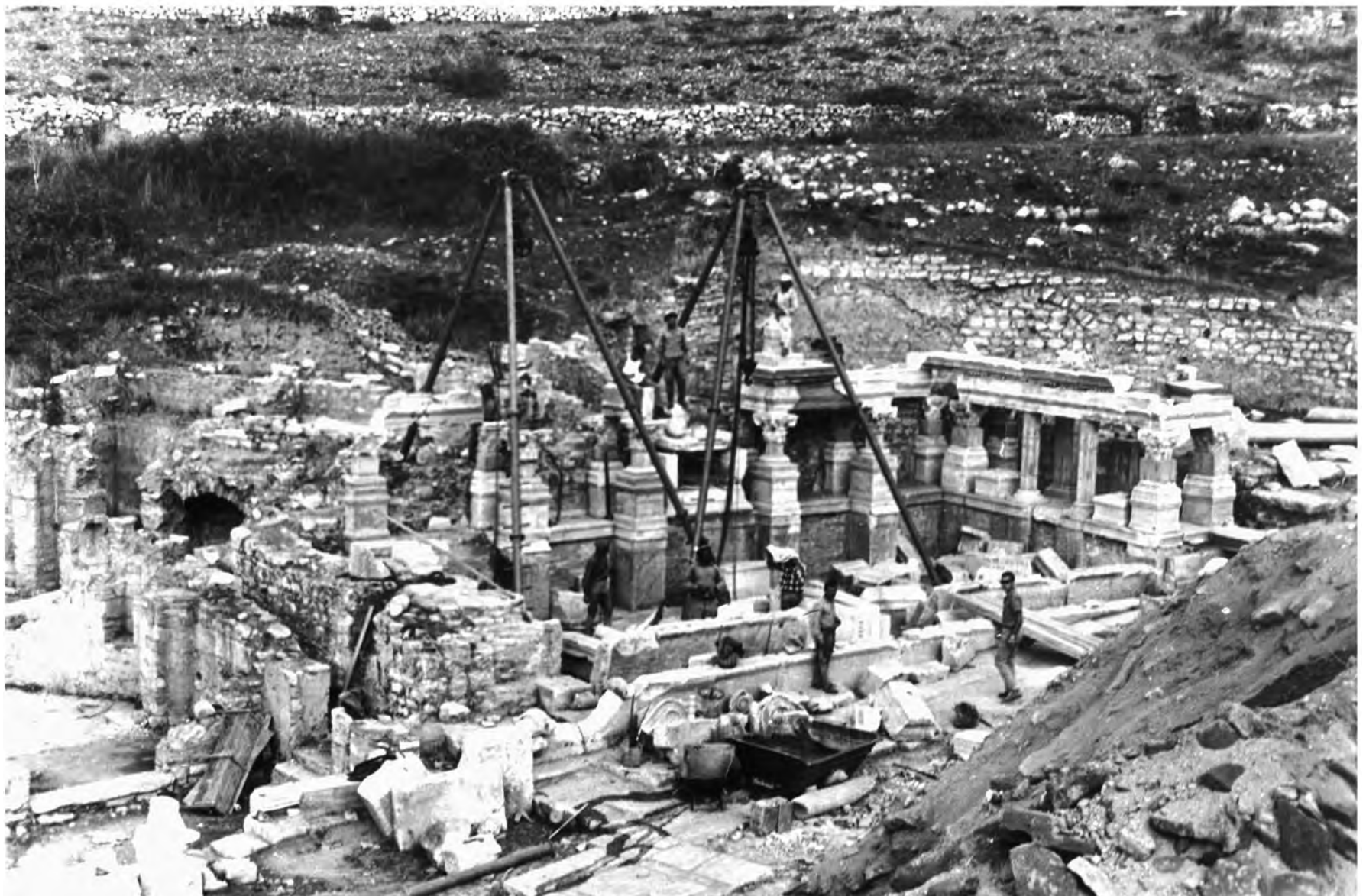
2 Aufstellen der Architekturprobe 1962
