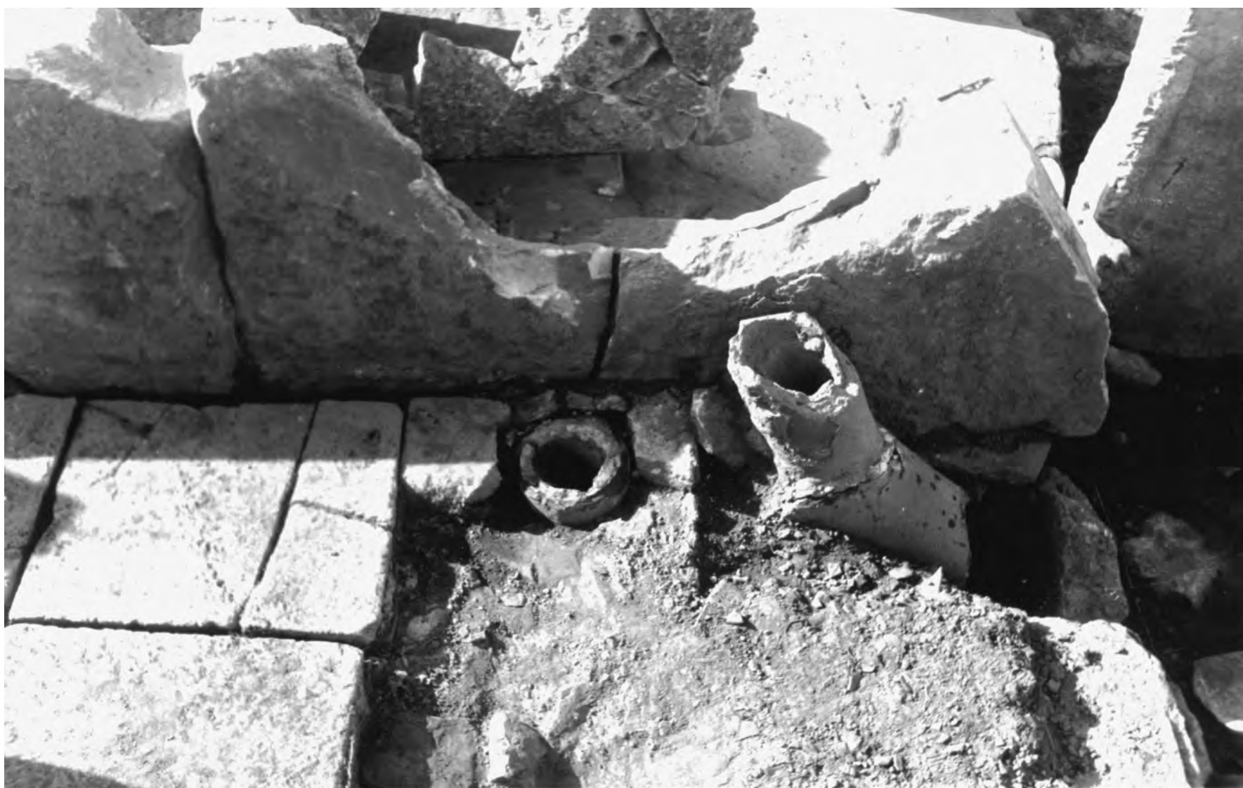
1 Tonrohr am westlichen Ende des Schöpfbeckens
