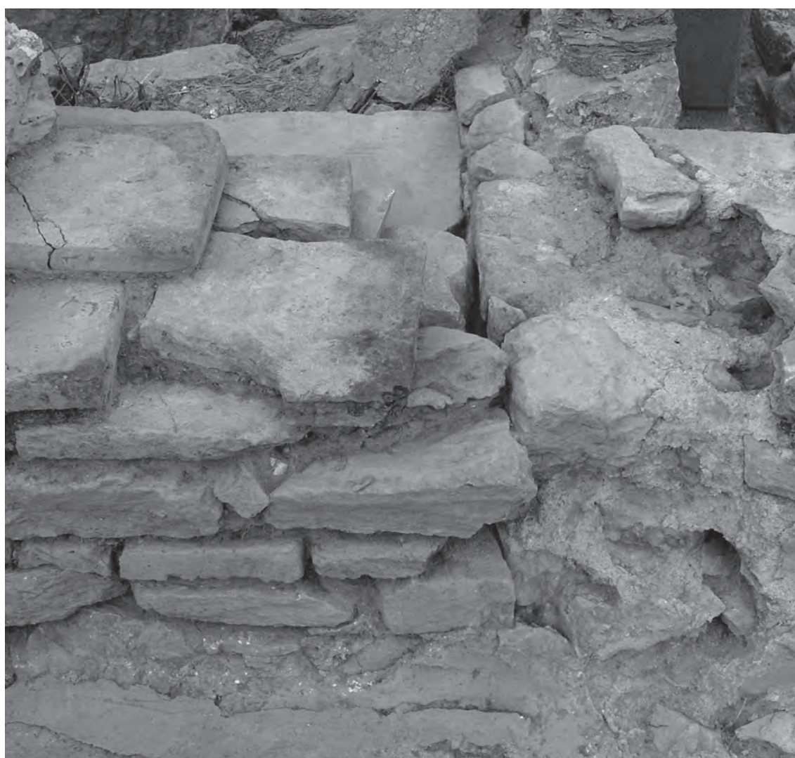
2 Nordöstliche Außenecke der Rückwand von Norden mit Ausbesserung in Ziegeln
