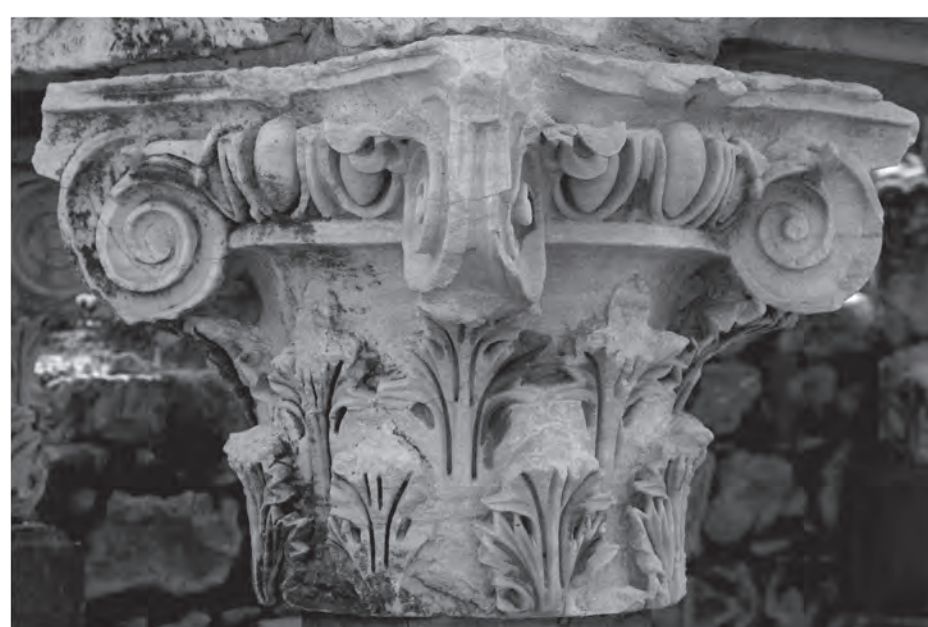
6 Säulenkapitell 4-7, Ansicht von SW
