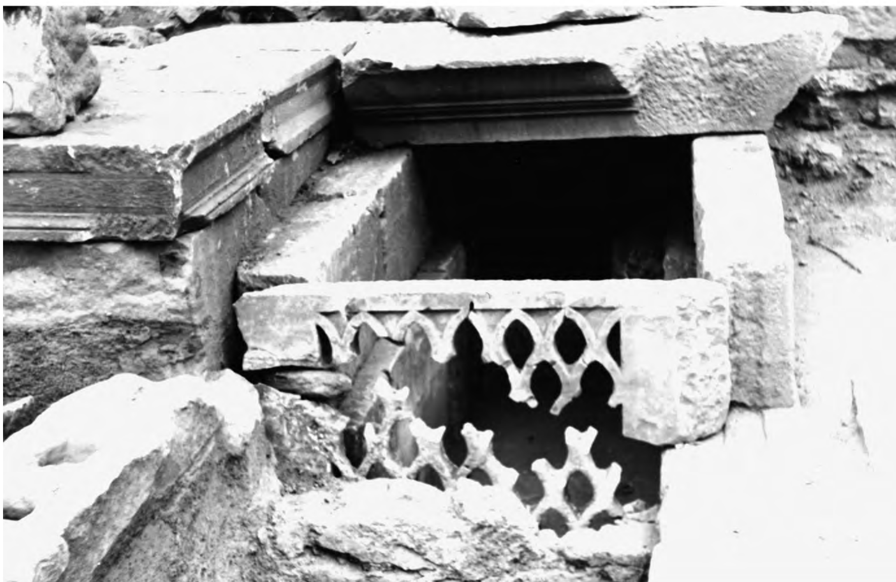
2 Steingitter vor dem Abfluß am Ostende des Schöpfbeckens
