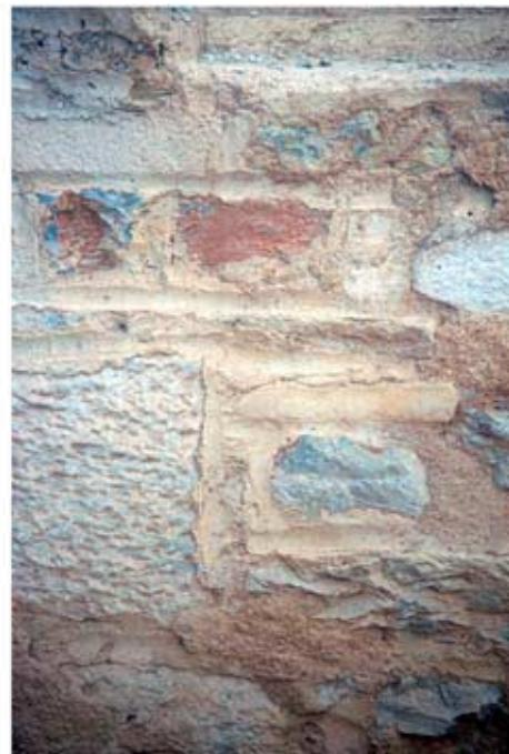
13.2: Quader-Bruchstein-Mauerwerk Typ 2
