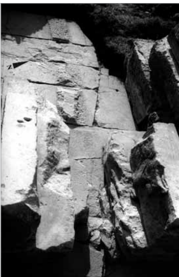
Südliche Sekoswand – vgl. Abb. 4: 1–4 Toichobatplatten, Westteil (~79 m östlich der AOK ), mit Details 5–7 Toichobat und unterste Wandschichten (~79 m und ~85 m östlich der AOK)
