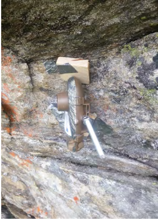
Abbildung 61: IN7 (Anmerkung: keine Fotoansicht auf die Monitoringfläche vorhanden; der Holzkeil zur Fixierung ist nicht notwendig)
