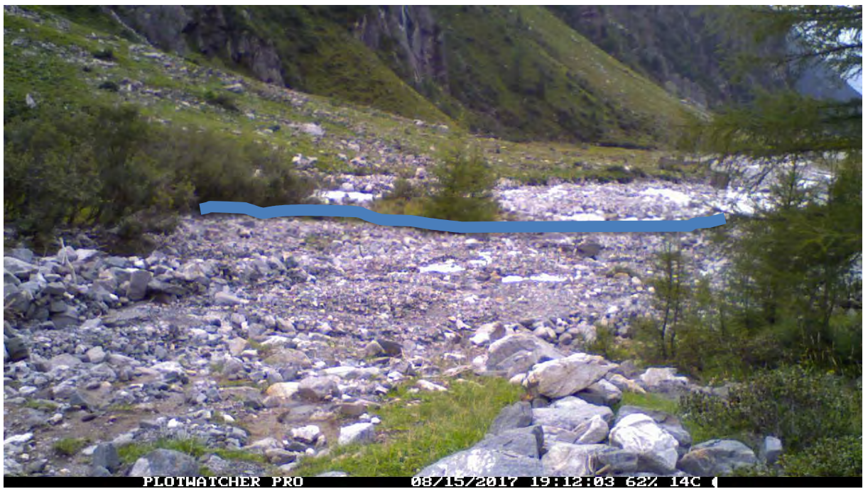
Abbildung 28: UN1 (vor der Zerstörung der Boden-Verankerung durch die Mure 2018)
