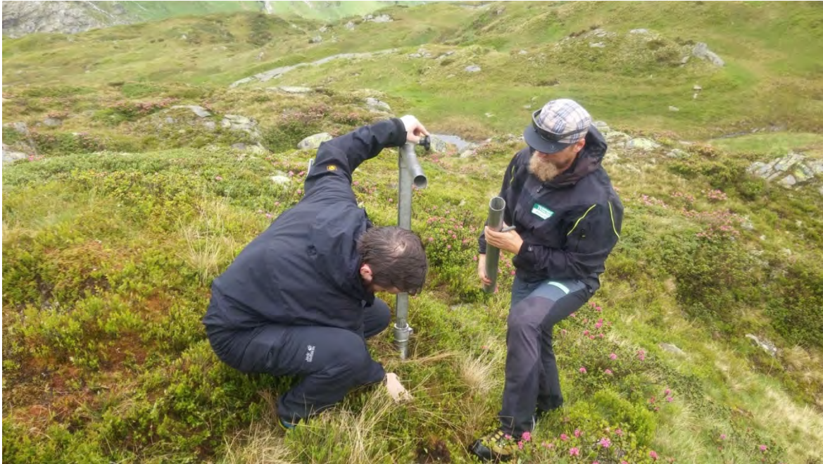
Abbildung 41: Eindrehen eines Erdnagels mit einem Drehschlüssel (aus dem Wanderwegebau) und 6 cm Durchmesser, 1m lange Eisenrundprofilstange (rechts in der Hand des NP Mitarbeiters); Standort IN4
