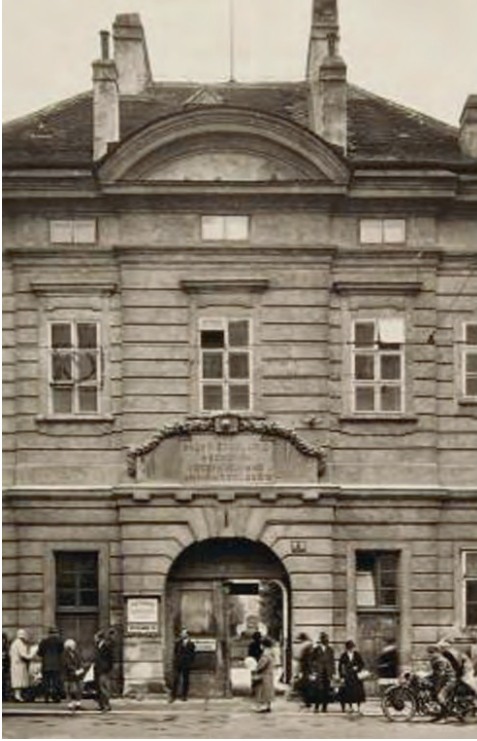
Fig. 42 Main entrance of the Allgemeines Krankenhaus, Alserstrasse 4
