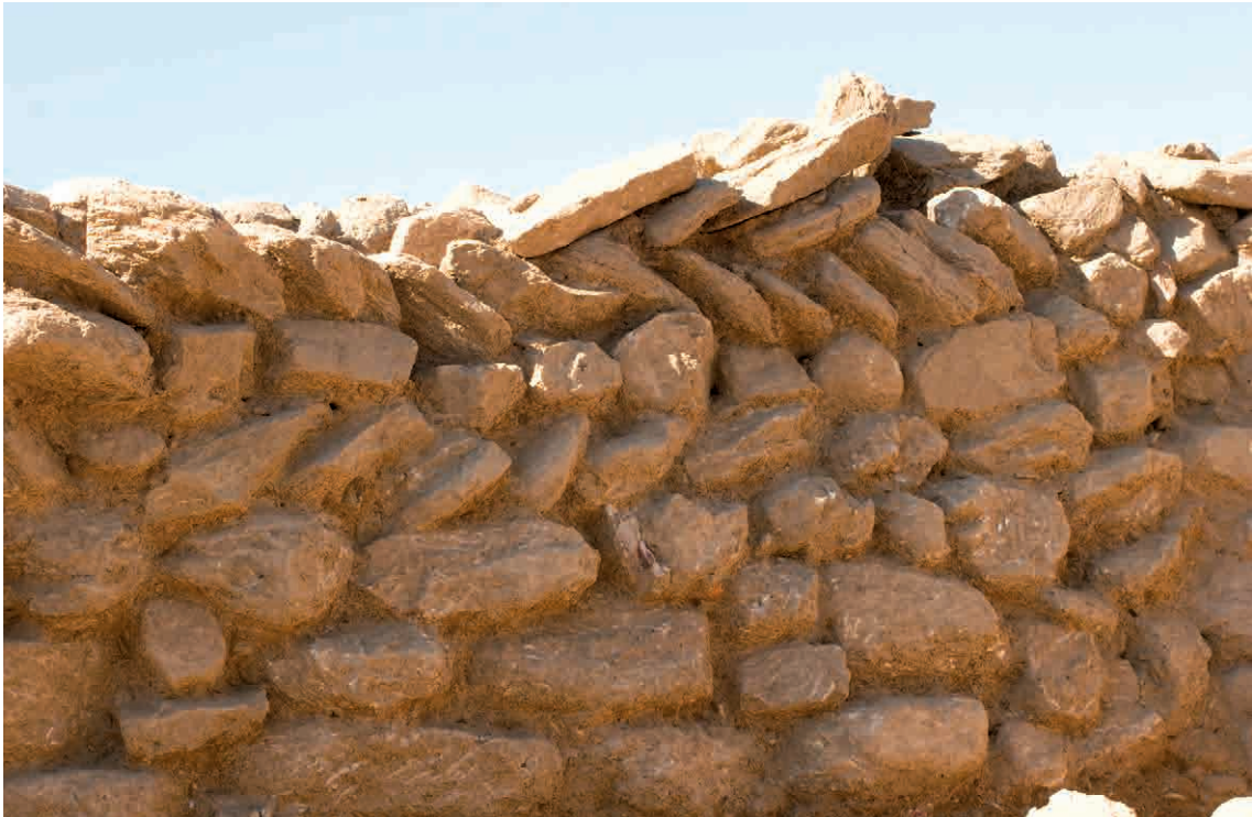
Abb. 105 Partielle Bautechnik mittels „Fischgrätenmauerwerk“ (Foto: T. Bratschi/Bauforschung Bratschi)
