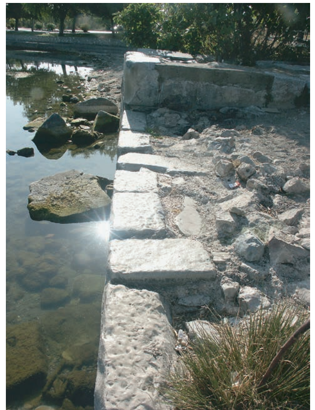
198 Nikaia, Kaimauern am See
