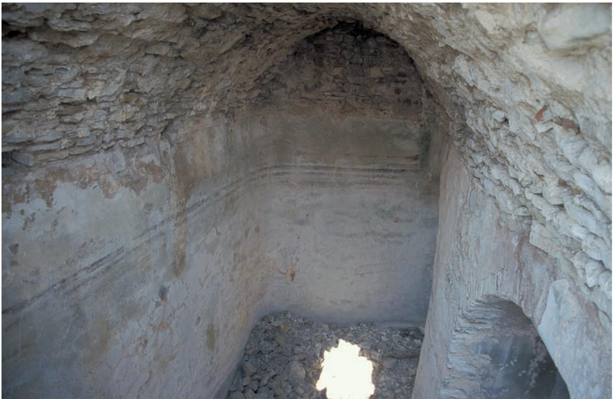
136 Kremastē, überwölbte Zisterne
