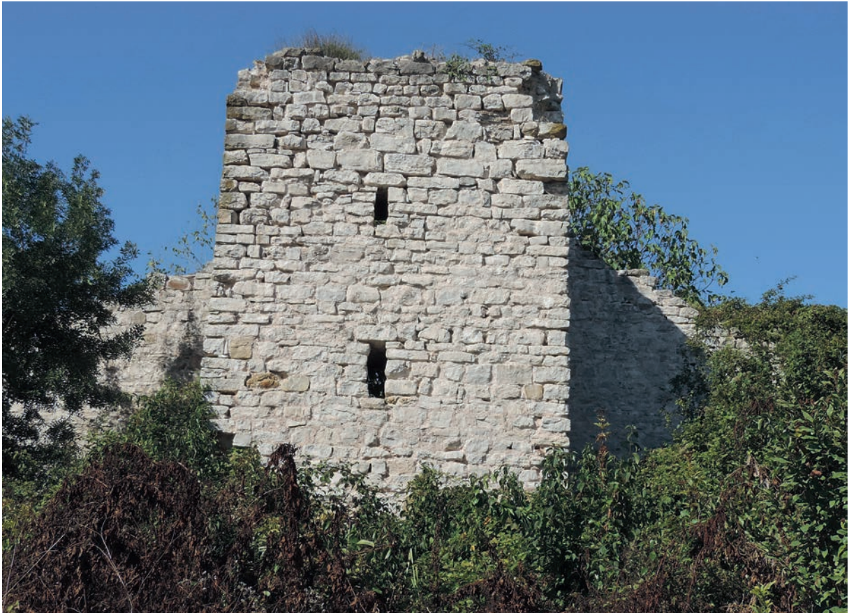
90 Harmantepe Kalesi, Turm mit Schlitzfenstern
