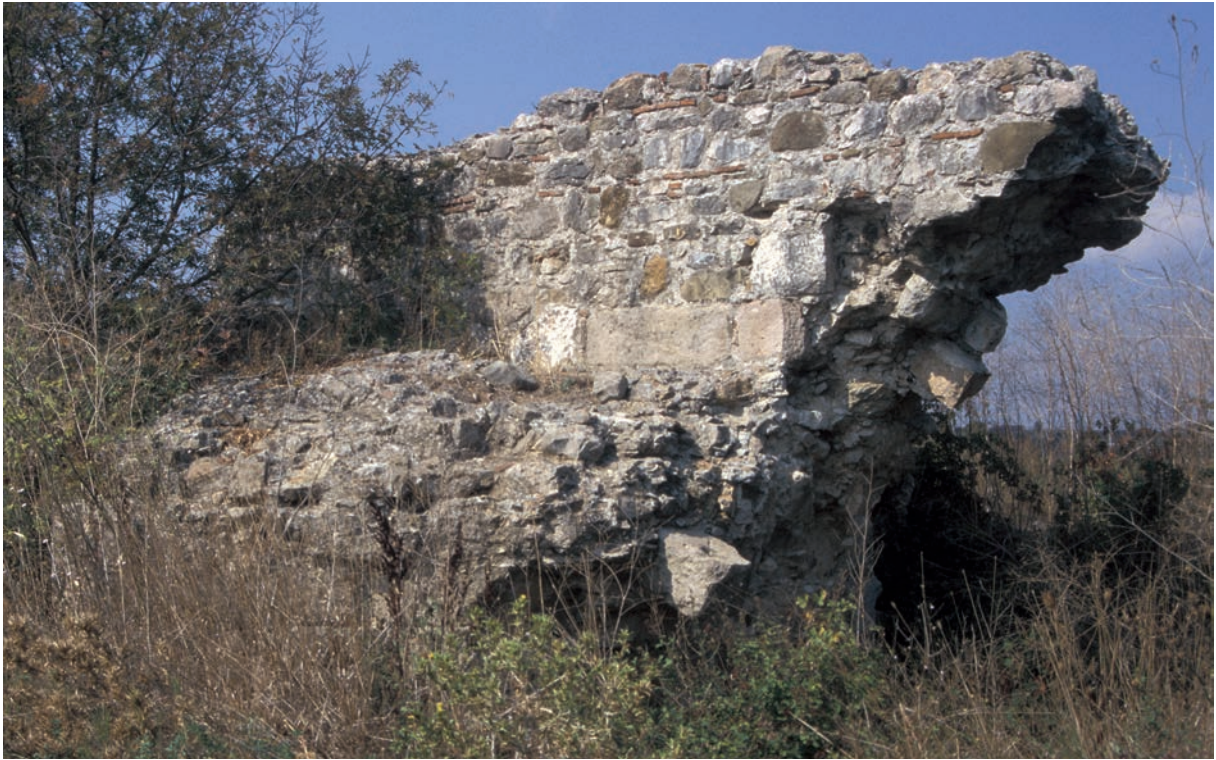
32 Akköprü, Brücke über den Granikos, Pfeiler
