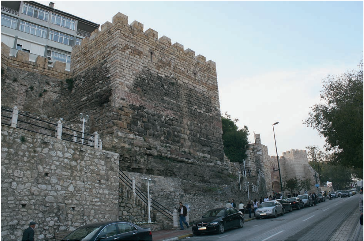
256 Prusa, teilweise wieder aufgebauter Turm der byz. Stadtmauer (2009)
