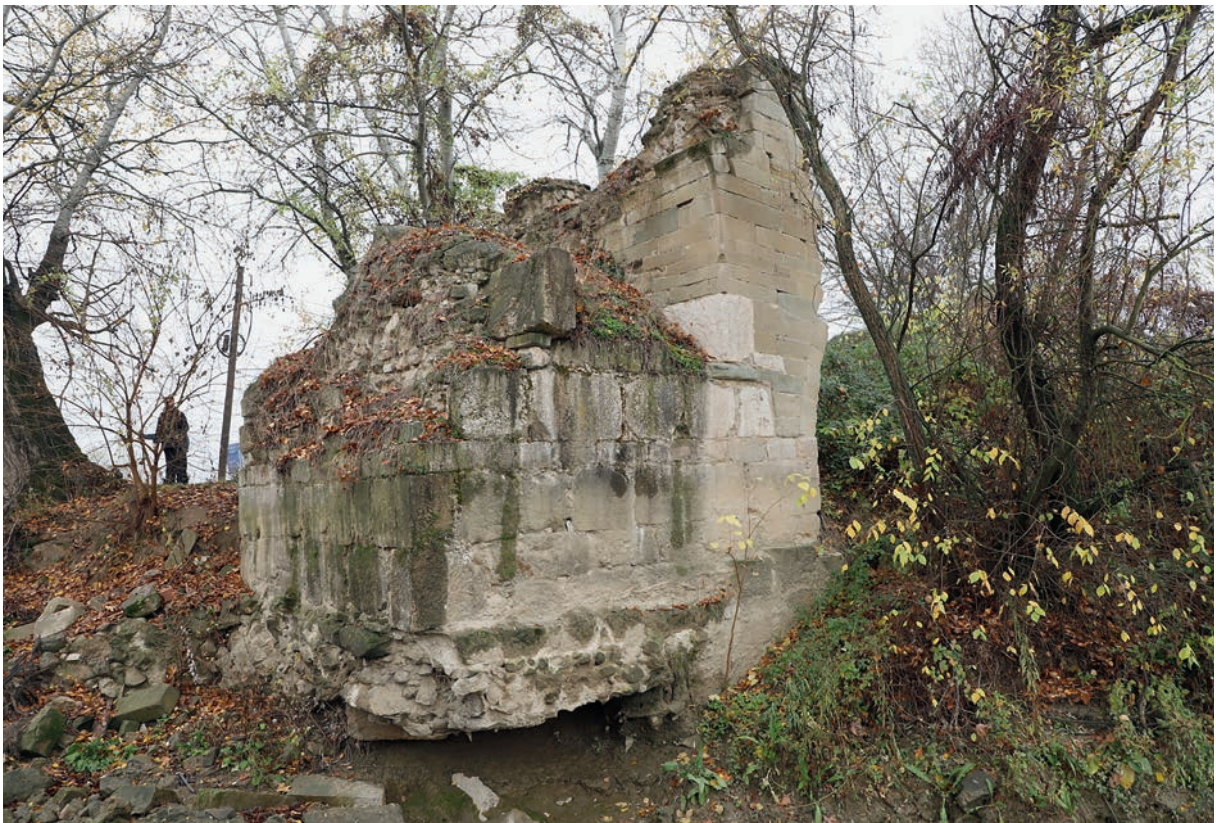
297 Taşköprü (2), alte Brücke, Pfeiler mit Ansatz des osman. Oberbaues
