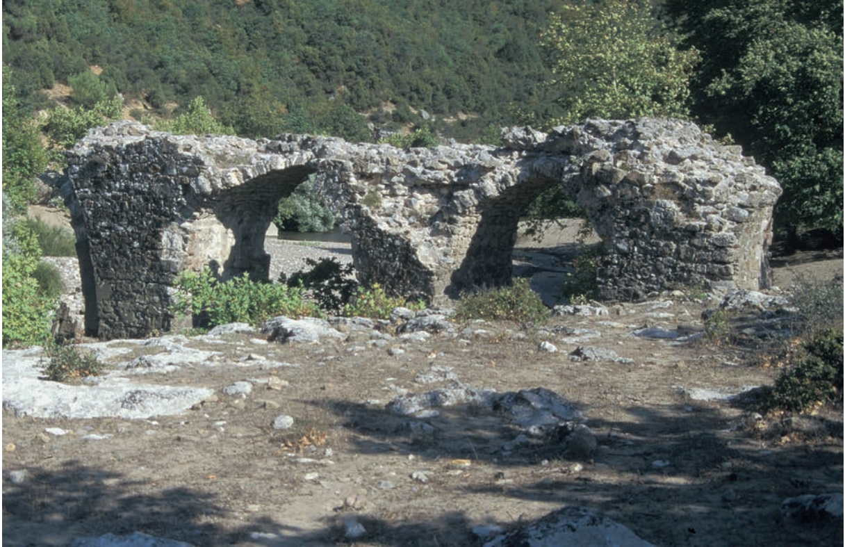
222 Palaia, alte Brücke
