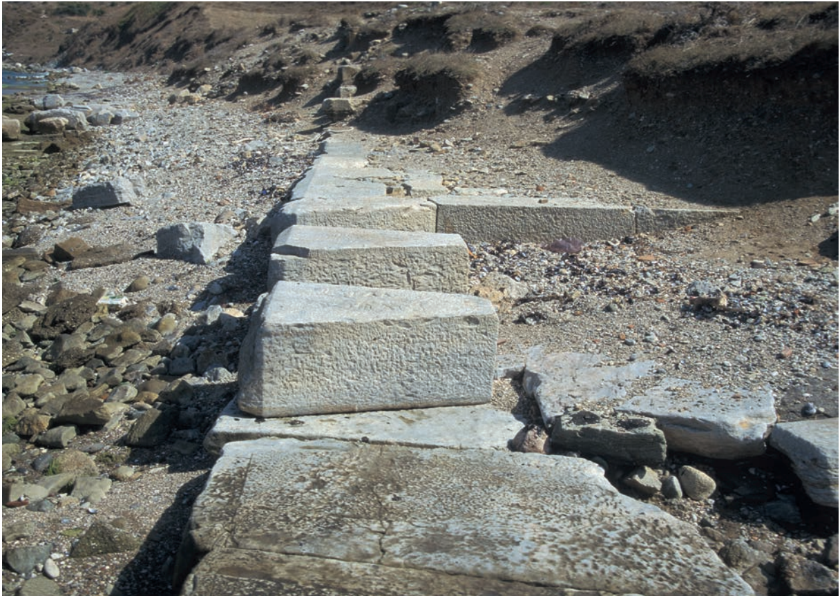
229 Parion, Kaimauern am Nordhafen
