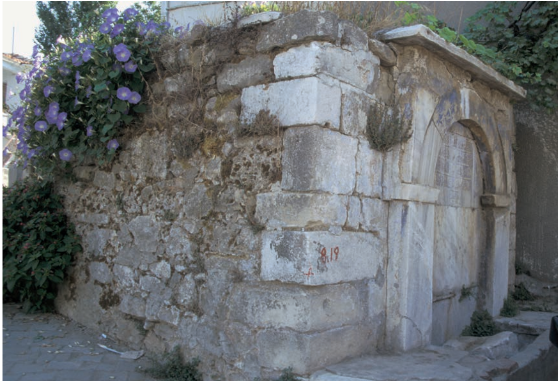
144 Lampsakos, Brunnen mit Spolienquadern und einem Stück byz. (?) Mauerwerk
