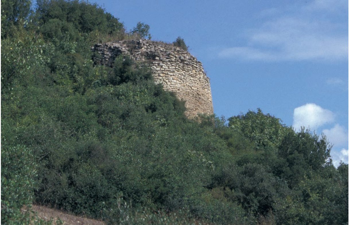
322 Xerigordos, Turm 4 (Zählung Foss) des Mauerringes
