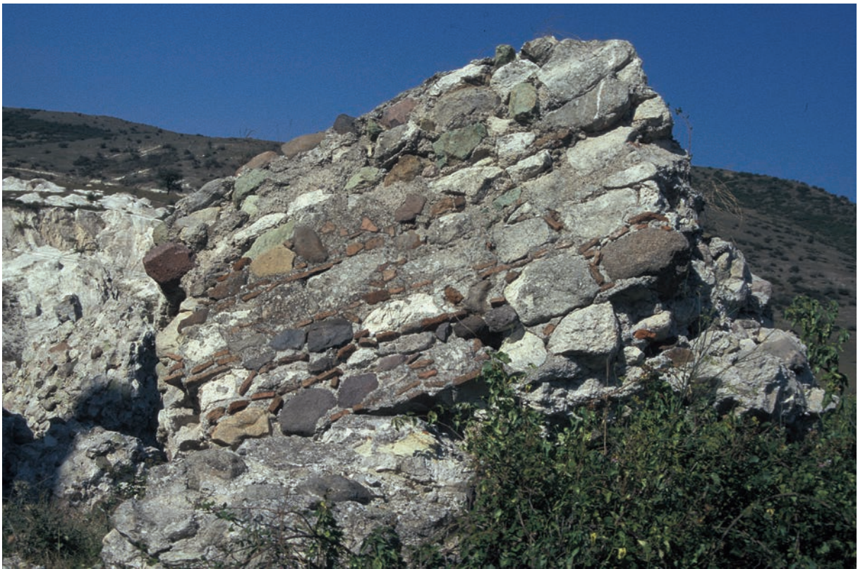
291 Sultançayır, Burg, herabgestürztes Mauerwerk mit intakter Außenschale
