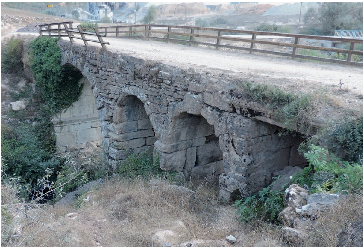
295 Taşköprü (1), alte Brücke von Norden
