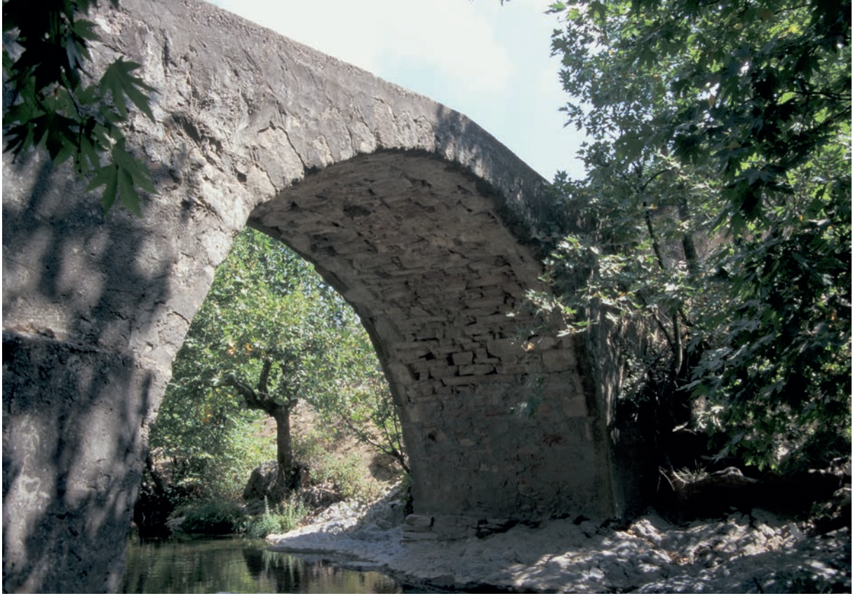
142 Lakku Mitata, osmanische Brücke 1
