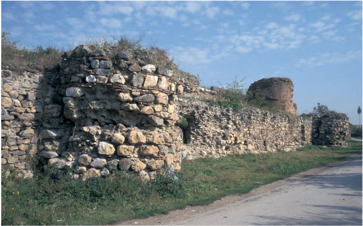
196 Nikaia, Vormauer Kaiser Iōannēs' III. Batatzēs mit Bastionen
