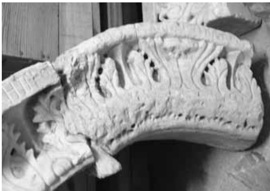
1a Sezione di arco contenente un'iscrizione (b), frammento arbitrariamente attaccato ad a, ma facente parte di un altro arco
